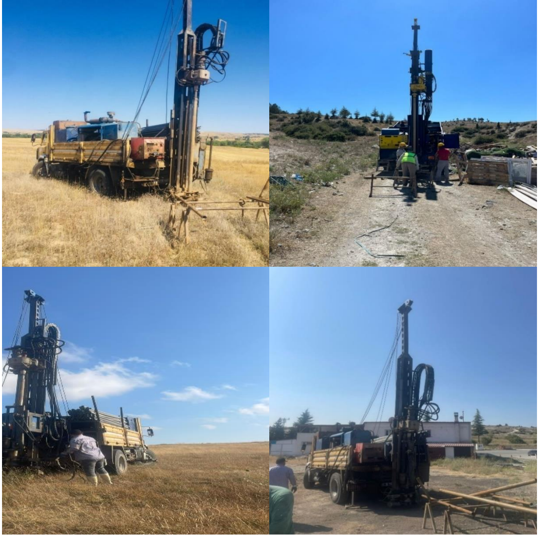
Şekil 4.1. Sondaj çalışmalarına ait fotoğraflar
