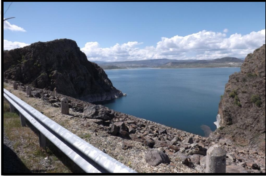
Şekil 34: Çamlıdere Barajı Bayındır Fayı.
