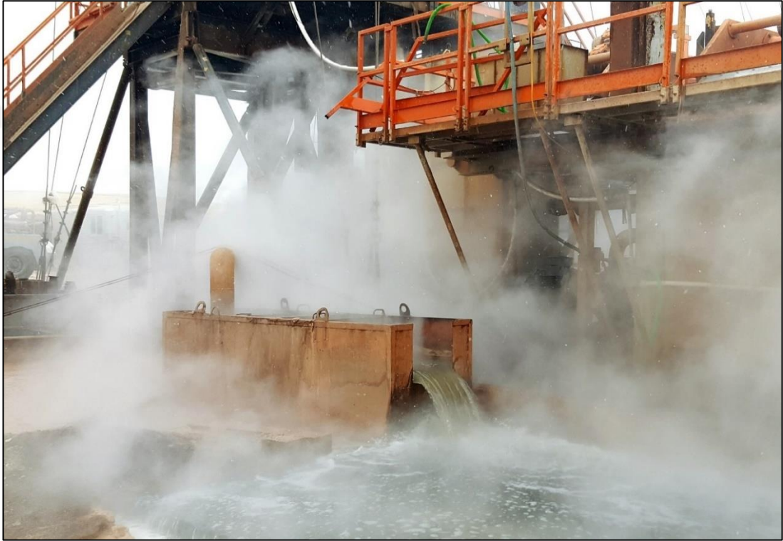
Şekil 4.23. KİS-2016/9 JAS kuyusunda asitleme sonrası yapılan üretim çalışmaları.
