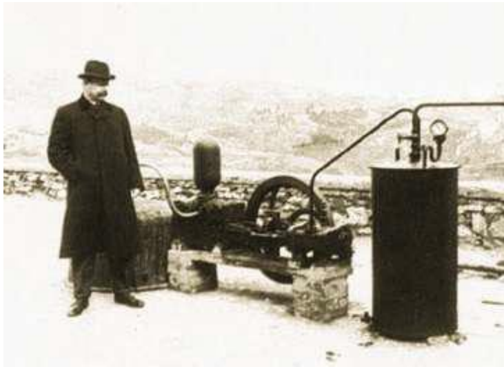
Resim 2.2. Mucit Prince Piero Ginori Conti ile birlikte 1904 yılında Larderello'da ilk kez jeotermal buhar enerjisi kullanılarak elektrik üretilen motor [Dickson ve Fanelli, 2004]
