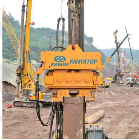
Şekil 4.6. Vibrasyon yöntemi ile muhafaza borusu çakılması / çekilmesi.
