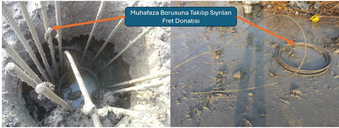
Şekil 4.5. Muhafaza borusuna takılıp sıyrılan fret donatısı.
