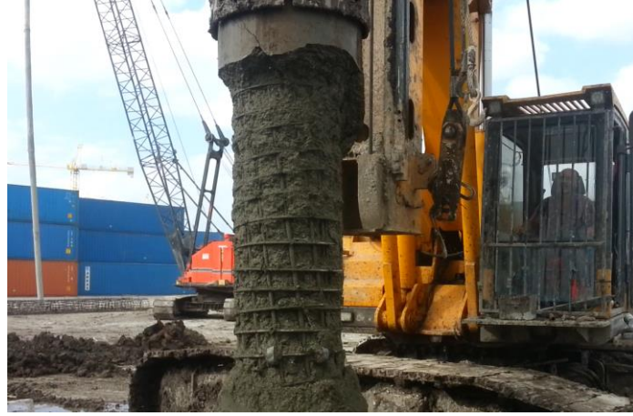
Şekil 4.4. Muhafaza borusu ile birlikte kuyu dışına çıkan kazık.
