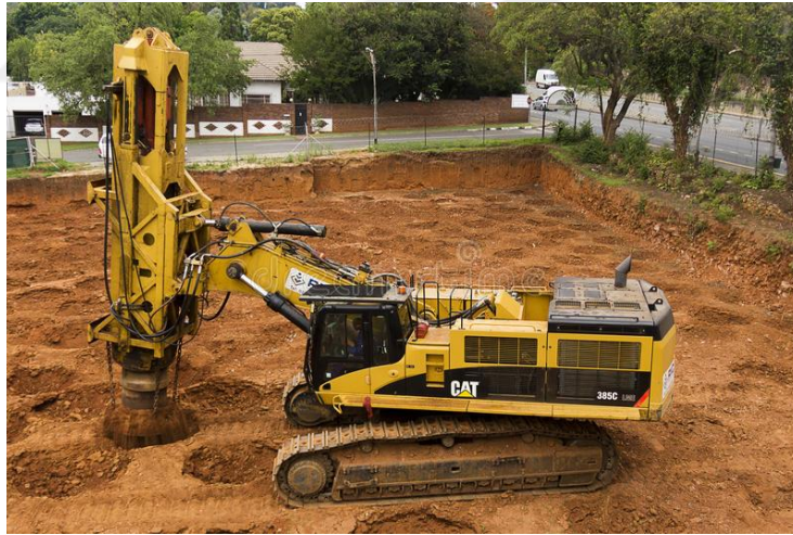
Şekil 2.6. Hızlı darbeli kompaksiyon (RIC) uygulaması.
