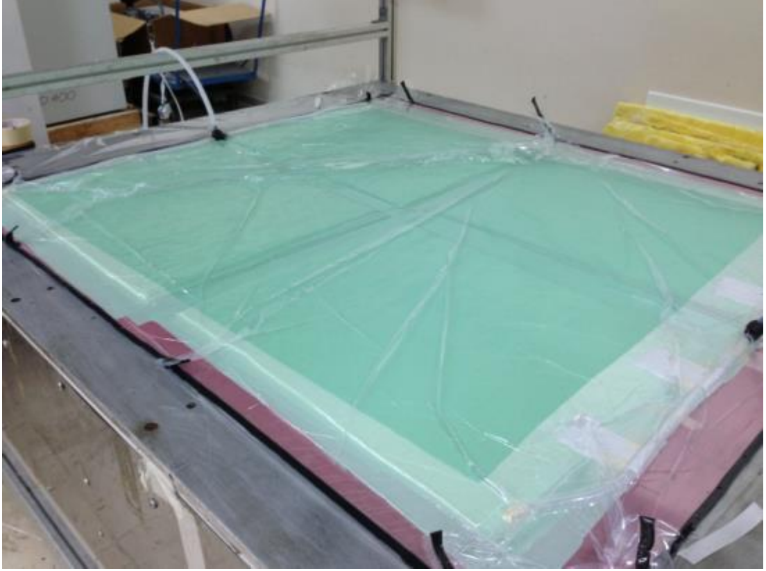
Şekil 2.15 Sistemin epoksi verilmesine hazırlanması
