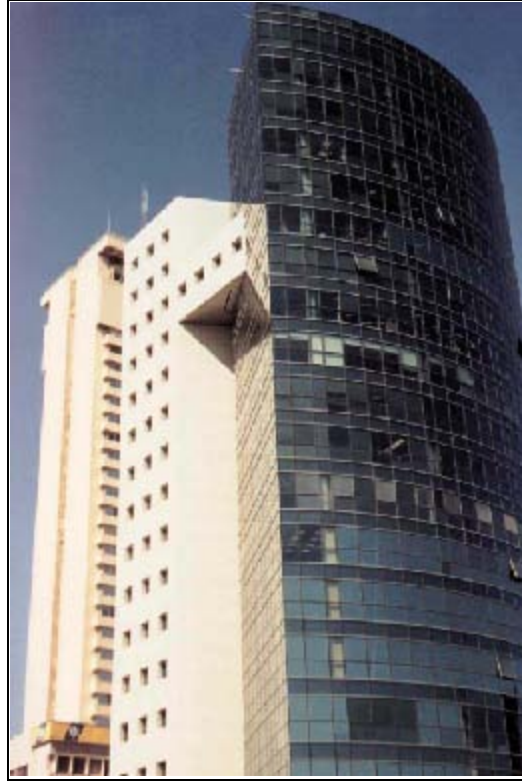
Şekil 5.16 İsrail de G.Afrika elçilik binası
