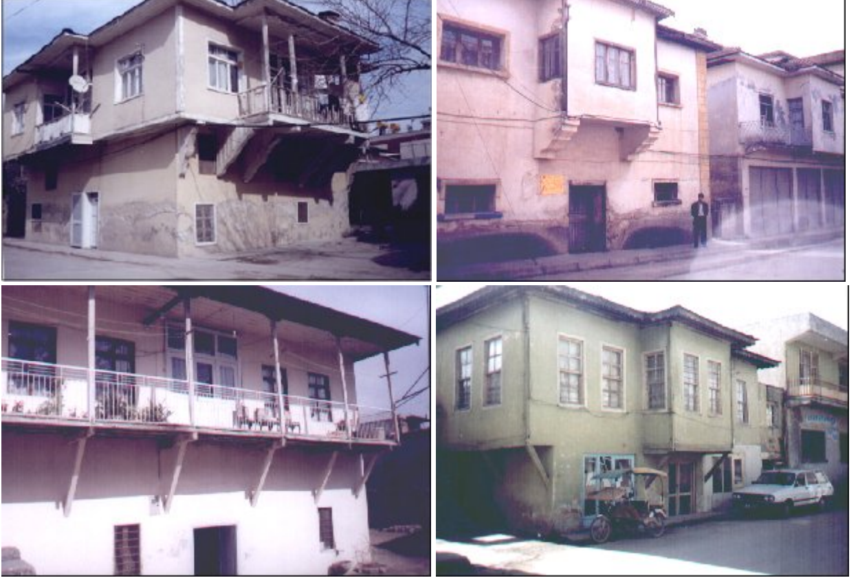
Foto: 3.30. Şehirde yer alan ahşap karkaslı taş meskenlerden görünüm. Selanik göçmenlerine ait ahşap karkaslı taş meskenler genellikle Bağ ve Pazar mahallelerinde yer almaktadırlar. Çoğunlukla 2 kattan oluşan ve alt katları genellikle kiler ve depo olarak kullanılan bu meskenlerin sayıları giderek azalmaktadır. Bu meskenlerin bazılarında ise geleneksel yapı korunarak evlerin etrafı surlarla çevrelenmiştir (2001).
