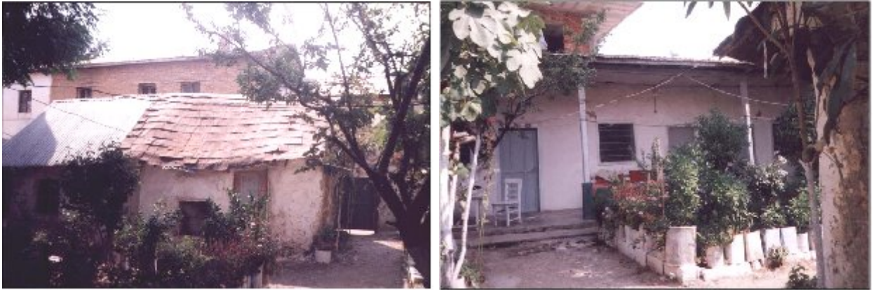
Foto: 3.29. Pazar mahallesinde yer alan "Huğ" evlerden görünüm. Tek odalı olarak inşa edilen ve üzeri saz, kamış vs. ile kapatılan bu meskenler, günümüzde yağmurun etkisinden korunmak ve dayanıklılığını artırmak için sac ve teneke parçalarıyla kapatılmaktadırlar. Kamış, saz, çalı ve direklerin yan yana örülmesi suretiyle duvarlar oluşturulmaktadır. Evlerin inşa edilmesinden kısa bir süre sonra çeşitli böcek ve haşerelerin duvarların içerisinde barınmalarını önlemek amacıyla, iç ve dış cepheleri balçıkla sıvanmakta ve böylece dayanıklılığı ve ısı izolasyonu da artırılmaktadır (2001).
