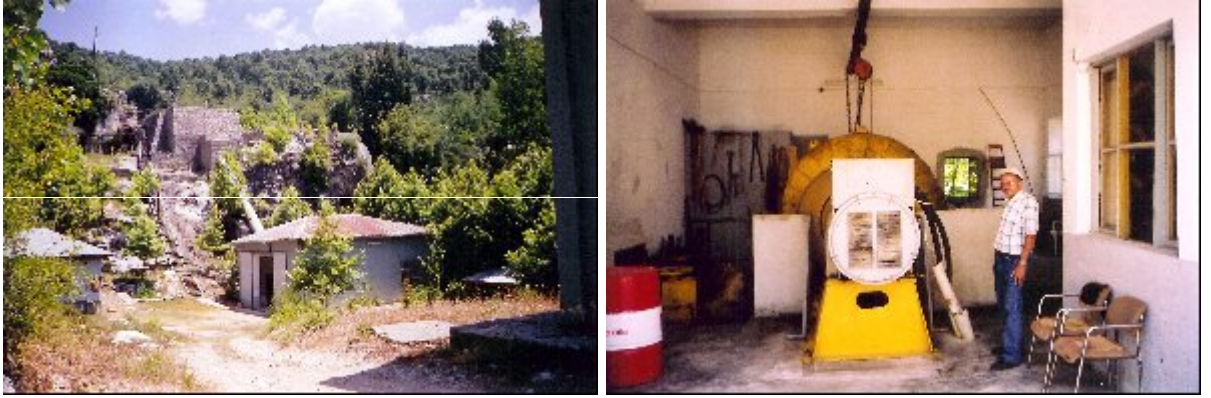
Foto: 1.6. Değirmendere H.E.S, Keşiş Suyu’nun kollarından biri olan Tahta suyu vadisindeki bir eğim kırıklığının oluşturduğu şelalenin hidroelektrik potansiyelinin değerlendirilmesi amacıyla, Değirmendere köyü merkez mahallesinin Yeşildere mevkiinde kurulmuş küçük bir hidroelektrik santral.
