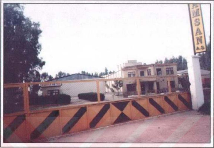
Foto 3.36. 1984 yılında kütü pamuk çırcırlama amacıyla kurulan Pamsan Çırcır Fabrikası, 1990'lı yıllardan itibaren bu işlevini sürdürmemiş ve 1995 yılında kapanmıştır. Bu yıldan sonra ise fabrikaya mısır kurutma tesisi ilave edilmiştir ve hala bu amaçla çalışmaktadır (2001).
