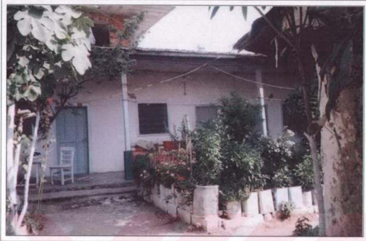
Foto 3.19. Dayanıklılığı daha da artırılmış, çatısı yenilenmiş, pencereleri büyütülmüş modern bir “Huğ” evi. 1960’lı yıllarda ağaç dallarının üst üste örülmesiyle ve balçıkla sıvanmasıyla yapılan bu huğ evi, günümüzde çeşitli konstrüksiyon değişiklikleri yapılarak daha kullanışlı hale getirilmiştir. Pazar mahallesi (2001).
