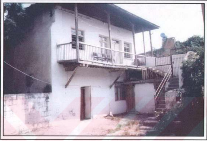
Foto 3.20. Tufan Paşa mahallesinde yer alan ahşap karkaslı taş meskenlerden bir görünüm. Bu meskenler genellikle 2 katlı olup, balkon, 2. kata çıkılan merdiven, tavan ve ara kat taban tamamıyla ahşap ile yapılmışlardır (2001).
