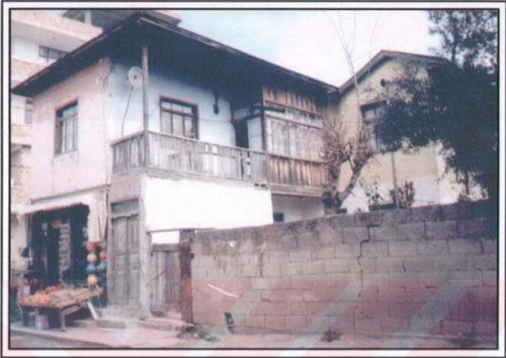
Foto 3.22. 1950'li yıllarda Kadirli'ye yerleşen Bulgaristan ve Selanik göçmenlerine ait bir mesken örneği. Bu meskenlerin bazılarının etrafı taş duvarla çevrili bahçe içerisinde yer alır. Bu tür evler Selanik ve Bulgaristan'da yaşayan Türk göçmenlerinin kültürel yaşantılarını Kadirli'de de yansıtmaktadır (2001).
