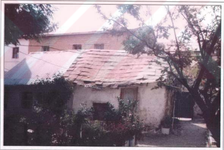
Foto 3.18. Pazar mahallesinde yer alan “Huğ” evlerden bir görünüm. Tek odalı olarak inşa edilen ve üzeri saz, kamyş vs. ile kapatılan bu meskenler, günümüzde yağmurun etkisinden korunmak ve dayanıklılığını artırmak için sac ve teneke parçalarıyla kapatılmaktadırlar (2001).
