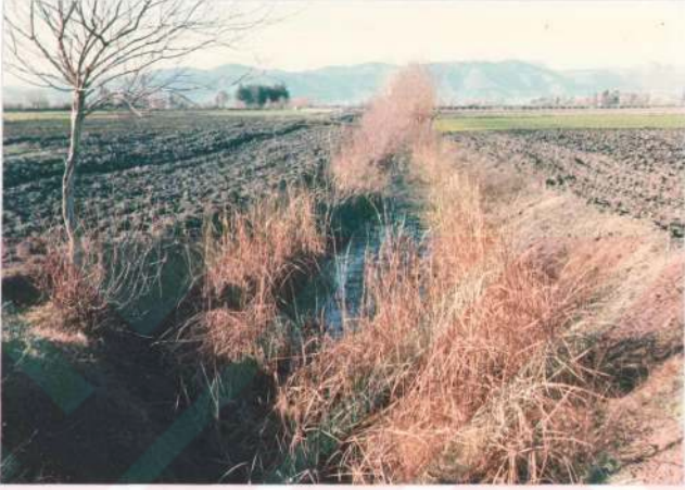
Resim 4.2. Kesiksuyu Sulaması D2-2a Yüzey Drenaj Kanalında Rüşubat ve Yabancı Ot Sorunu
