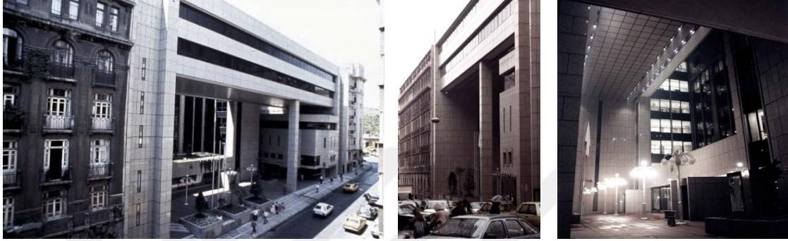
Şekil 2.13. Milli Reasürans T.A.Ş. Genel Müdürlük Binası (Arkiv 2021b).
