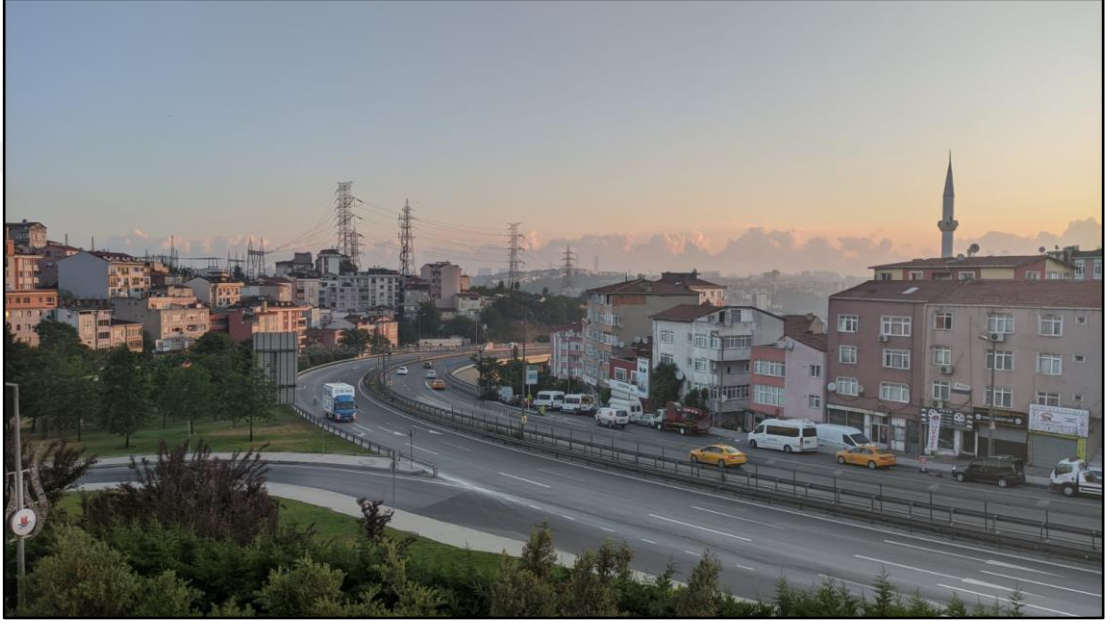
Fotoğraf 14: Okmeydanı-Hasdal Bağlantı Yolu
