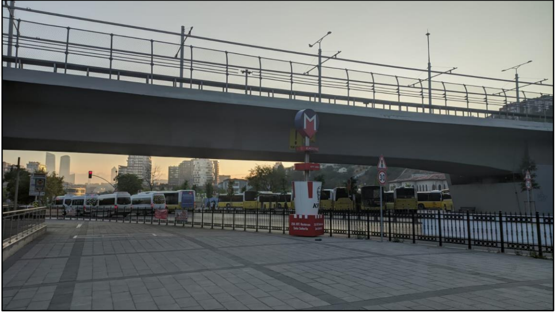
Fotoğraf 13: Mecidiyeköy-Mahmutbey Metro Hattı Kâğıthane İstasyonu
