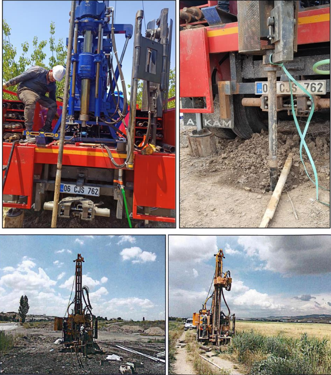
Şekil 6.5. Temel sondaj kuyularından örselenmemiş numune alınışı
