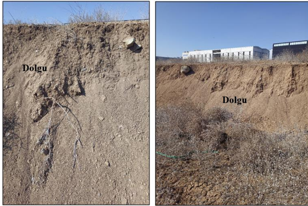
Şekil 6.3. İnceleme alanında dolgu birimin yüzeylendiği alanlardan görünüm.
