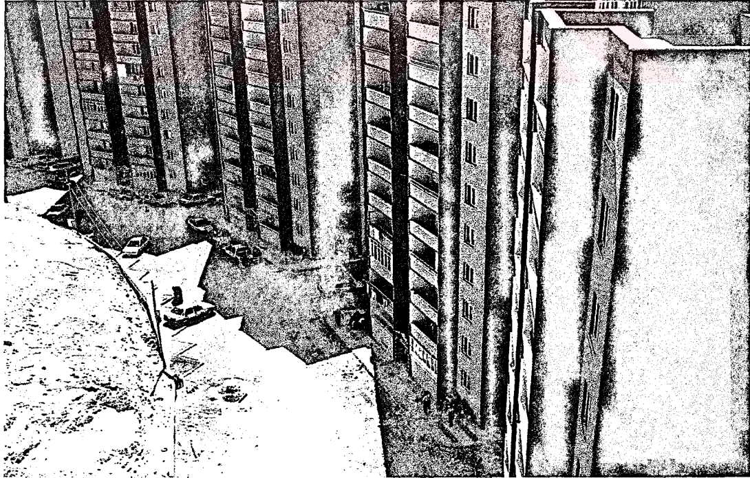
Şekil 5.53. Esentepe Toplu Konut Alanında Yapılan Otopark Alanı
