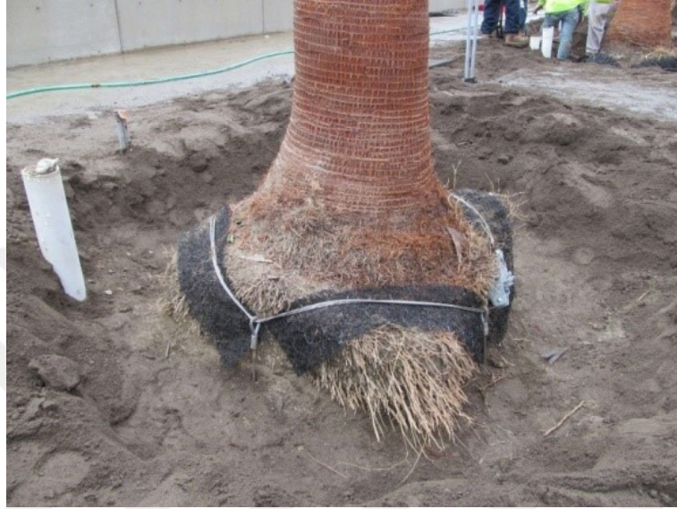
Şekil 7. Platipus Anchors bitki ankraj sistemi uygulaması (URL- 4, 2023)
