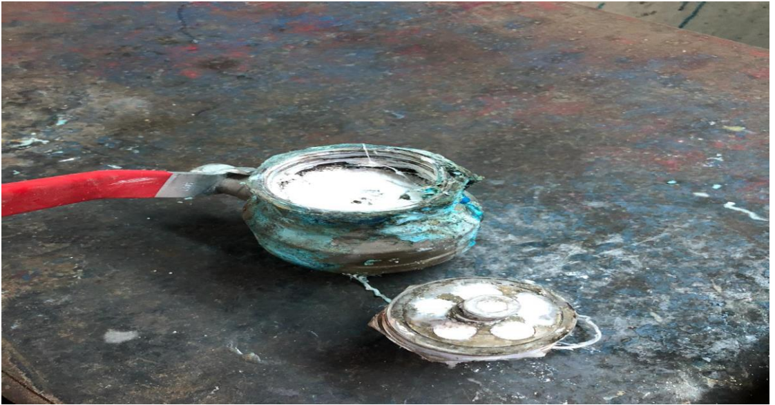
Şekil 4.6. Tutkal kolektörü giriş çekvalf ve vananın tıkalı hali.
