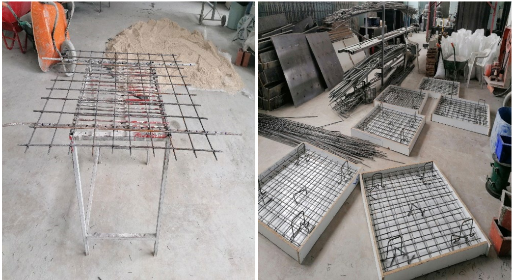
Şekil 3.19. Çelik hasır donatının kalıplara yerleştirilmesi
