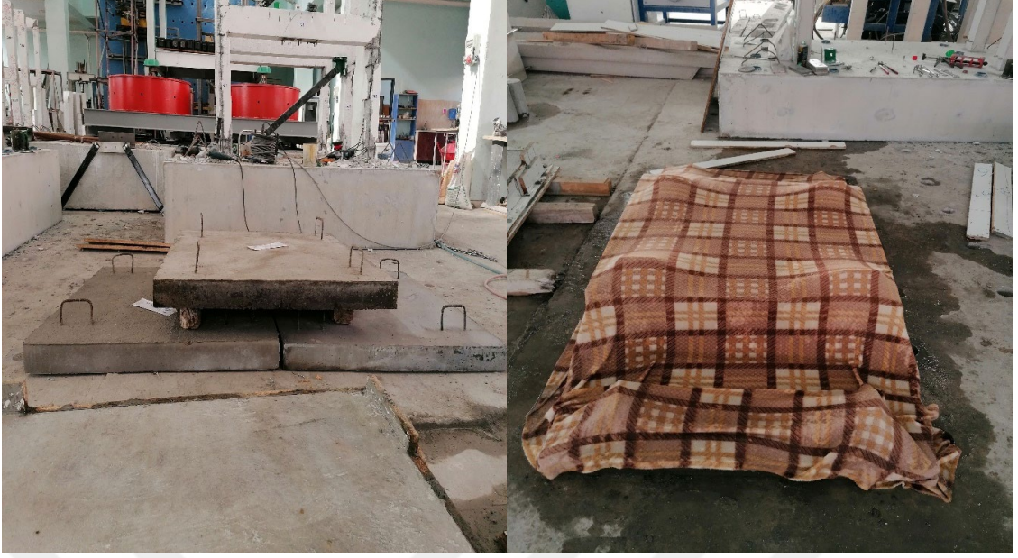
Şekil 3.22. Betonarme plak kür uygulaması
