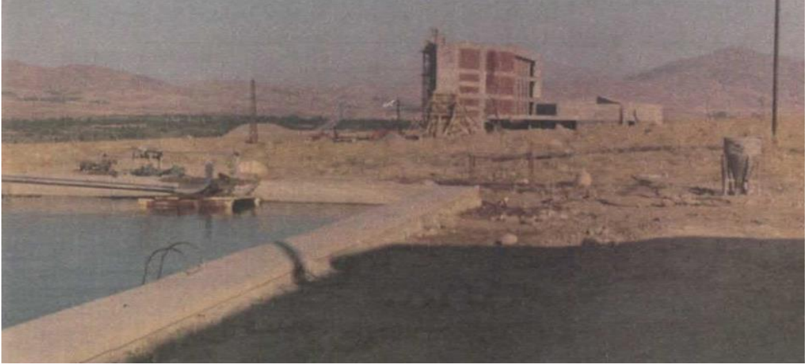
Şekil 4.4. Kampüs Fen-Edebiyat Fakültesi derslikleri inşaatı [27]
