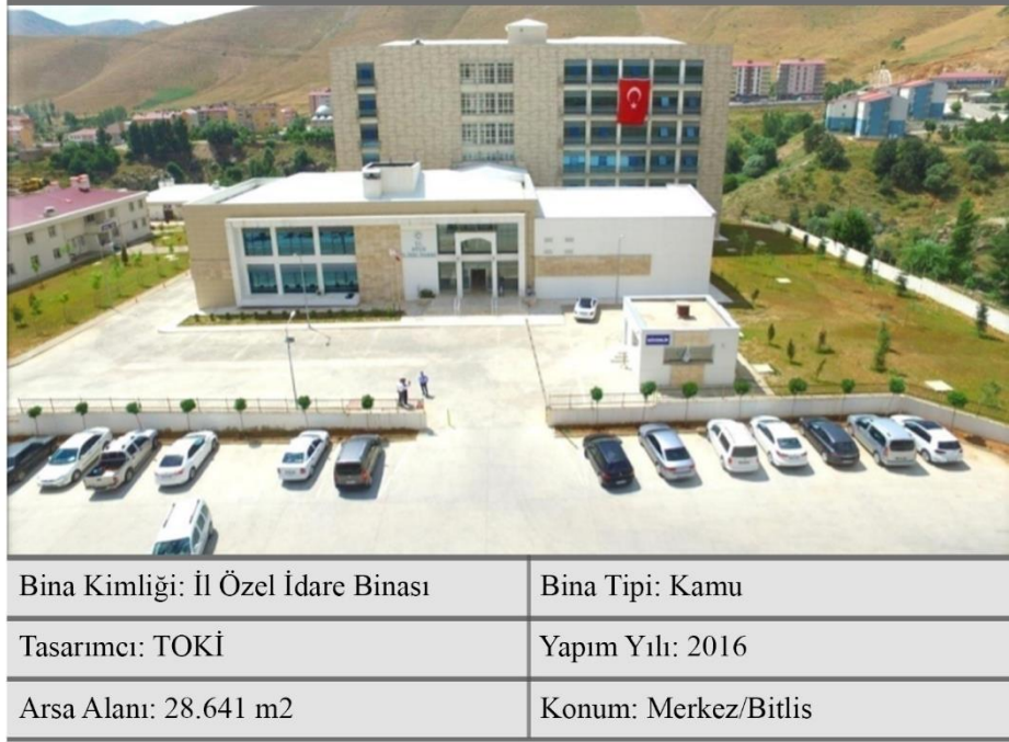
Şekil 80: Bitlis İl Özel İdare Binası
