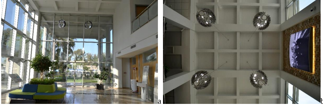
Şekil 58: Giriş mekânındaki aydınlatma ve havalandırmayı sağlayan biçimleniş unsurları: a) cam yüzeyler ve iklimlendirme menfezleri, b) Yapay aydınlatma
