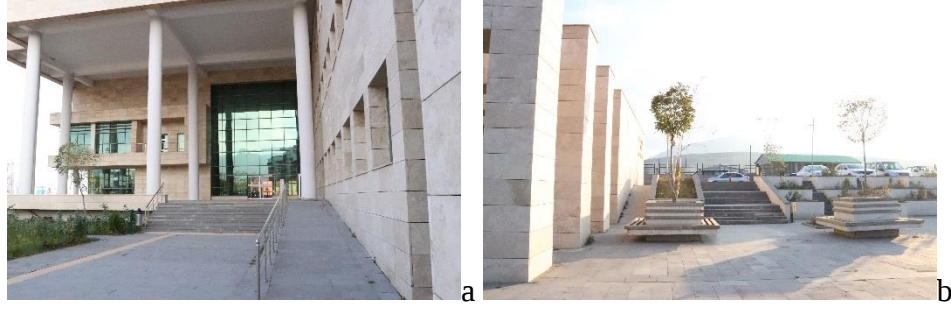
Şekil 76: a) Kamu girişi rampa ve merdiven uygulaması, b) Bahçe girişi rampa ve merdiven uygulaması
