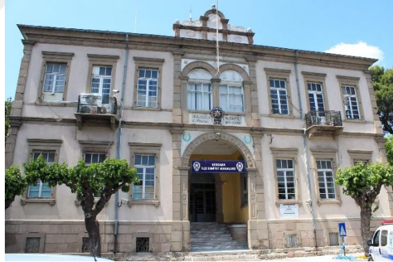
Şekil 28: Cepheden içe doğru çekilmiş giriş mekânı örneği, Bergama Hükümet Konağı (1903-1909)
