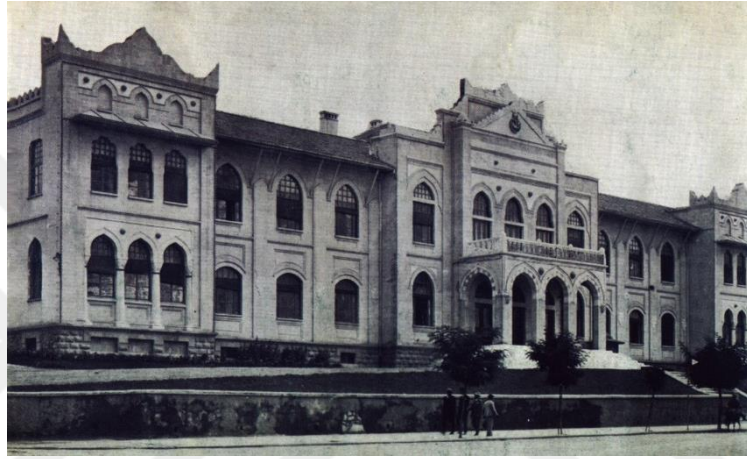
Şekil 29: Kemer detaylı, cepheden dışarı doğru taşan ve balkon taşıyan giriş mekânı örneği, Hariciye Vekâleti Binası, Ankara (1927)
