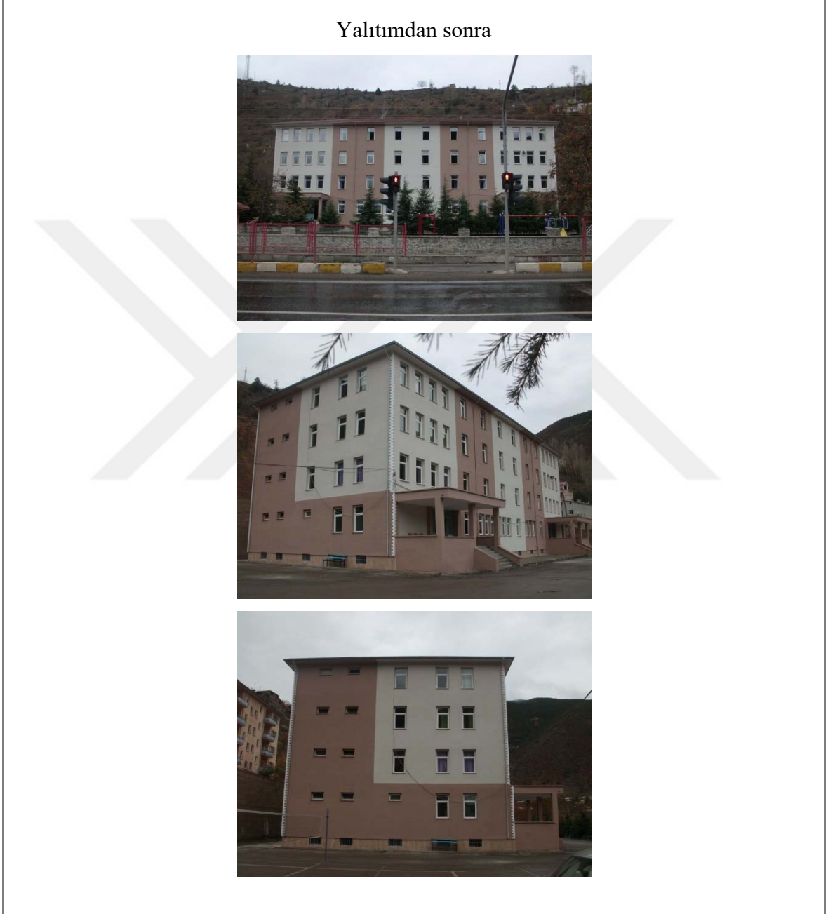
Şekil 2.108. Binanın yalıtımdan sonraki görüntüleri
