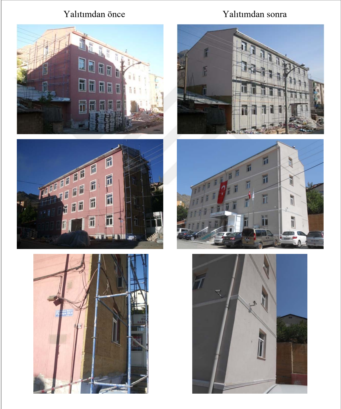
Şekil 2.61. Binanın yalıtımdan önce ve sonraki görüntüleri
