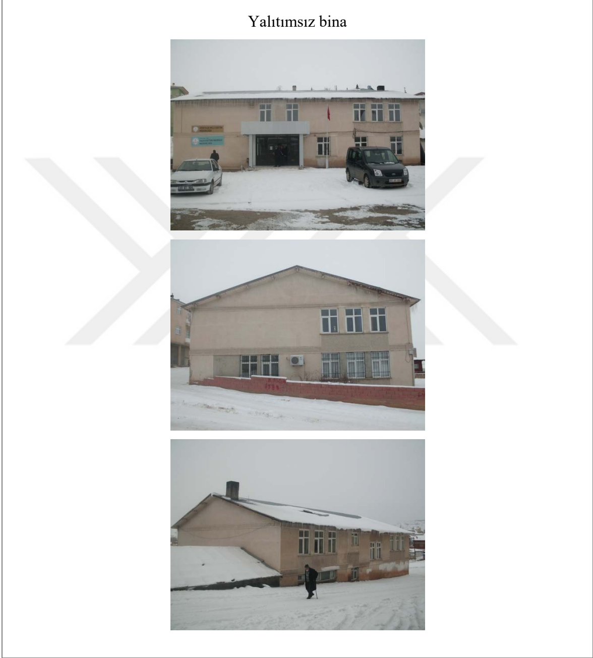
Şekil 2.95. Binanın dıştan yalıtımsız haldeki görüntüleri
