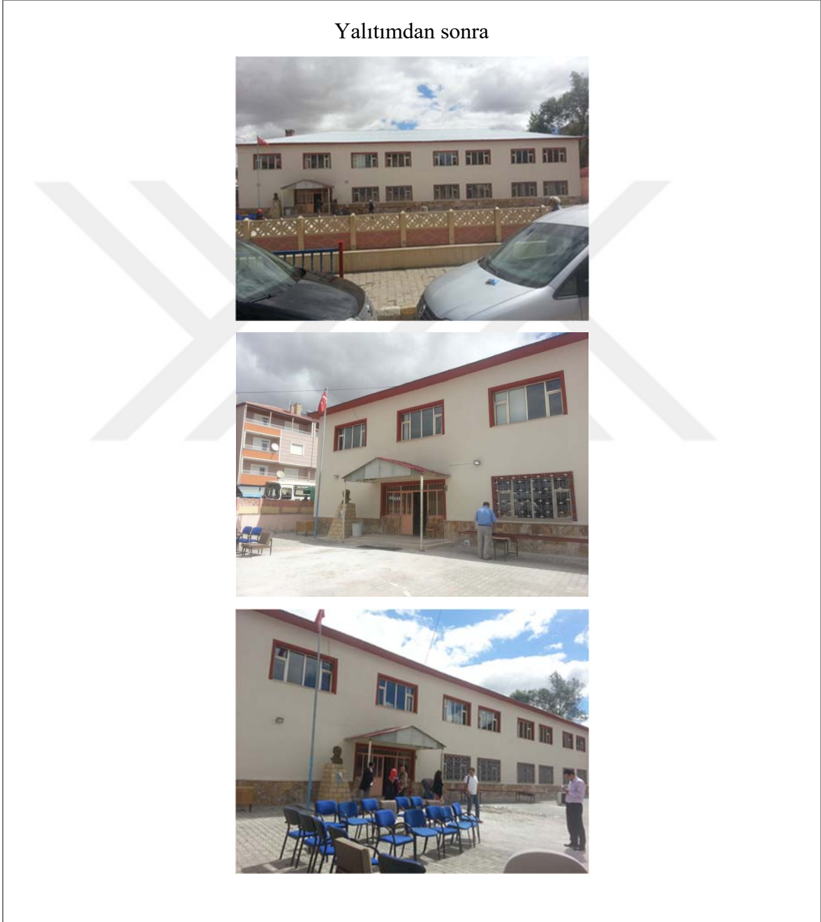
Şekil 2.74. Binanın yalıtımdan sonraki görüntüleri
