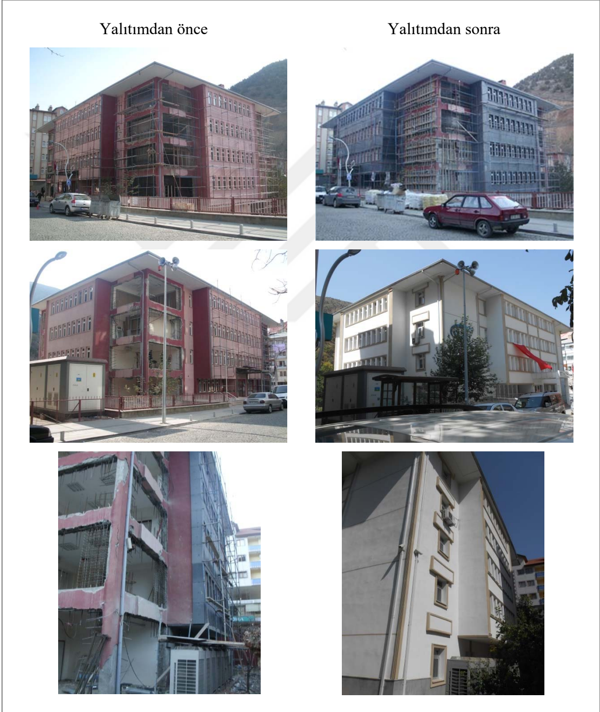
Şekil 2.70. Binanın yalıtımdan önce ve sonraki görüntüleri
