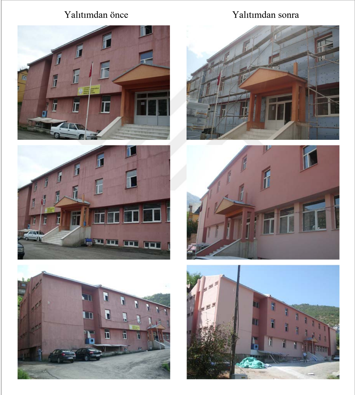
Şekil 2.48. Binanın yalıtımdan önce ve sonraki görüntüleri
