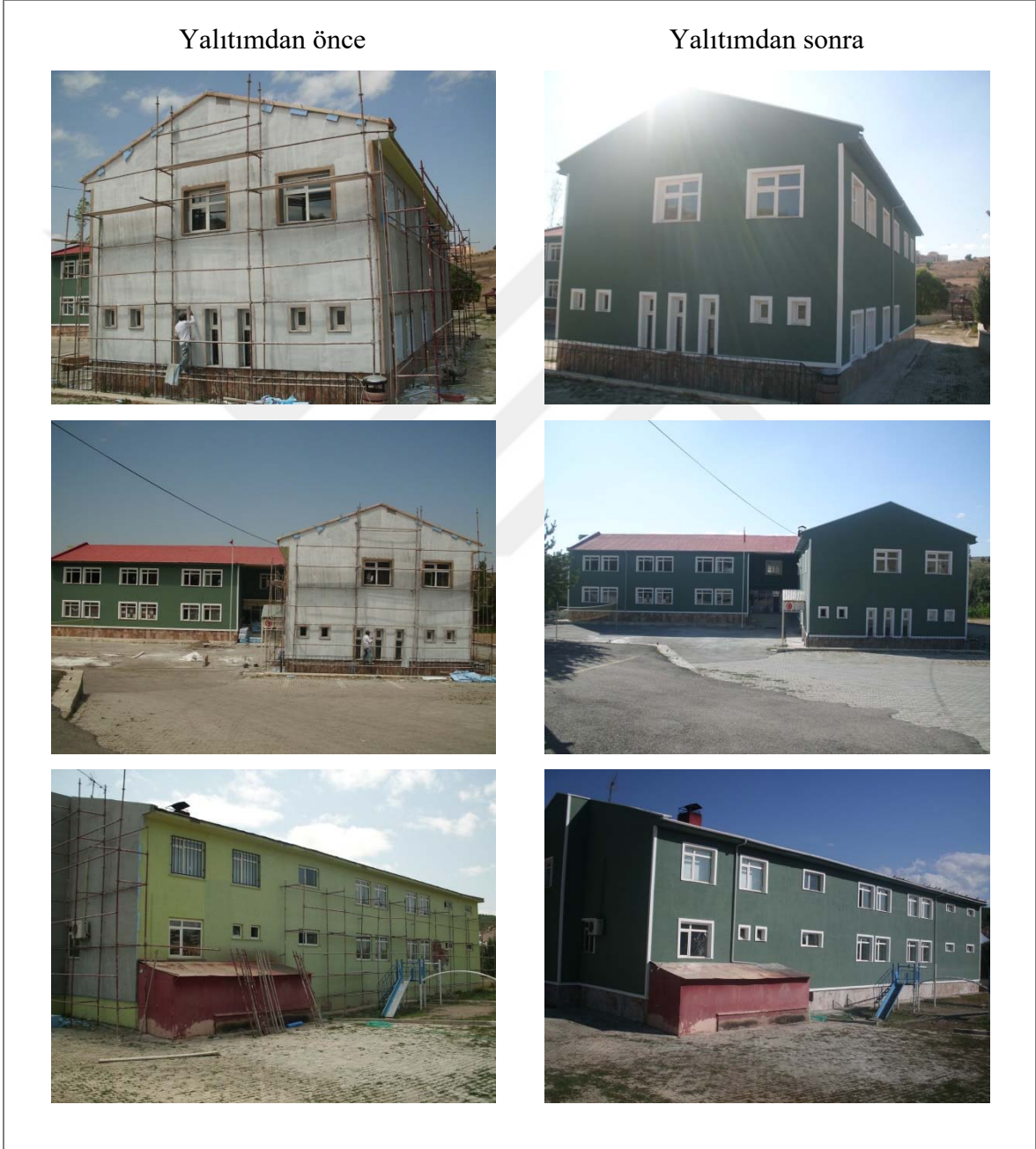
Şekil 2.99. Binanın yalıtımdan önce ve sonraki görüntüleri
