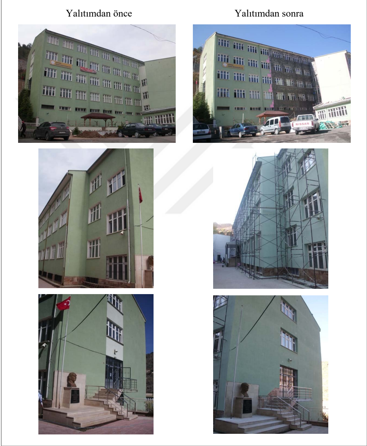
Şekil 2.65. Binanın yalıtımdan önce ve sonraki görüntüleri
