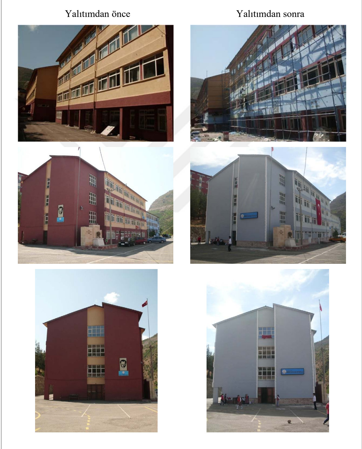
Şekil 2.52. Binanın yalıtımdan önce ve sonraki görüntüleri
