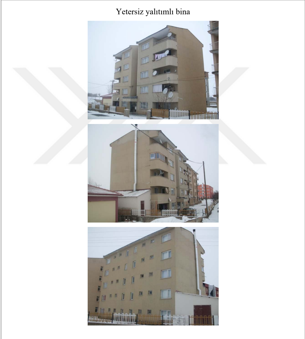
Şekil 2.78. Binanın dıştan yalıtımsız haldeki görüntüleri
