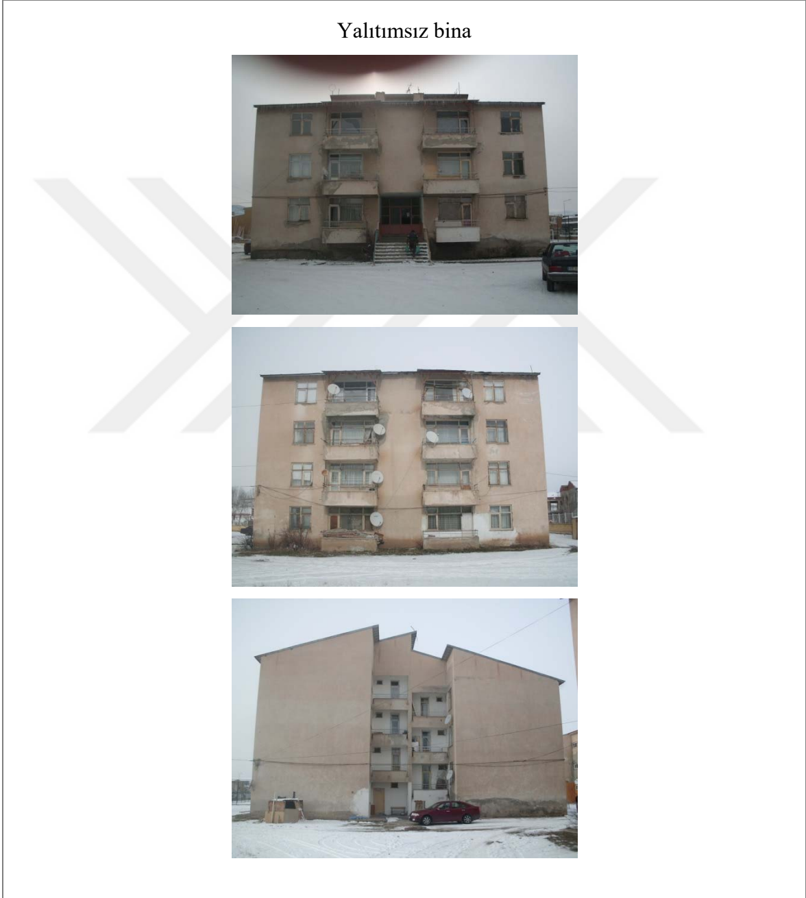
Şekil 2.82. Binanın dıştan yalıtımsız haldeki görüntüleri
