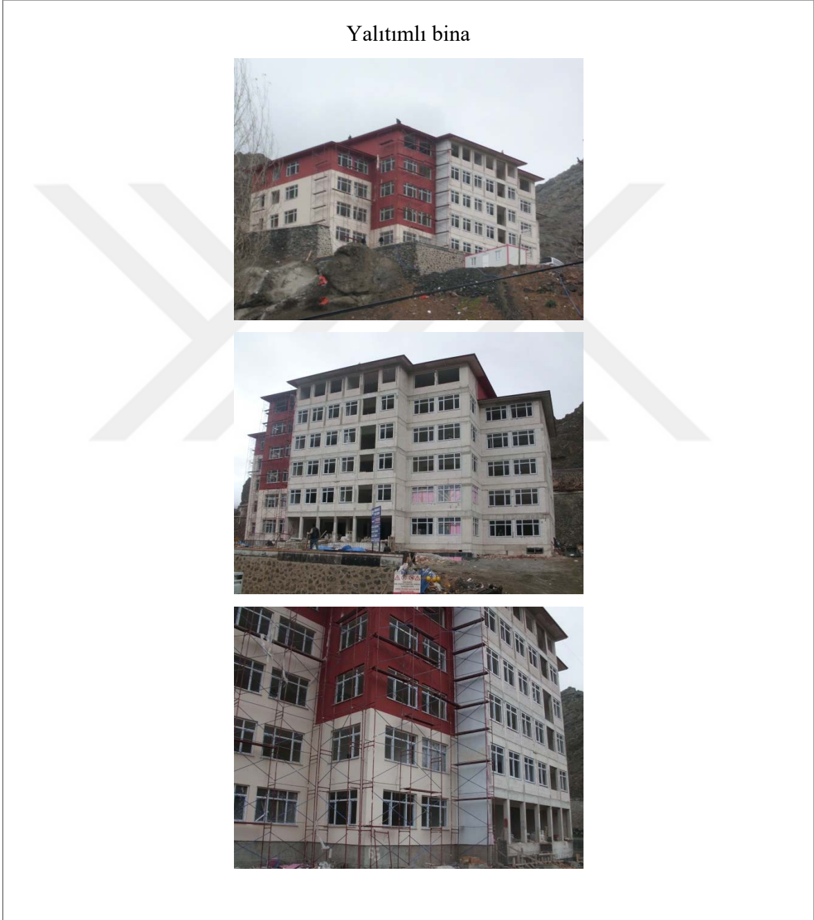
Şekil 2.57. Binanın dıştan yalıtımlı haldeki görüntüleri
