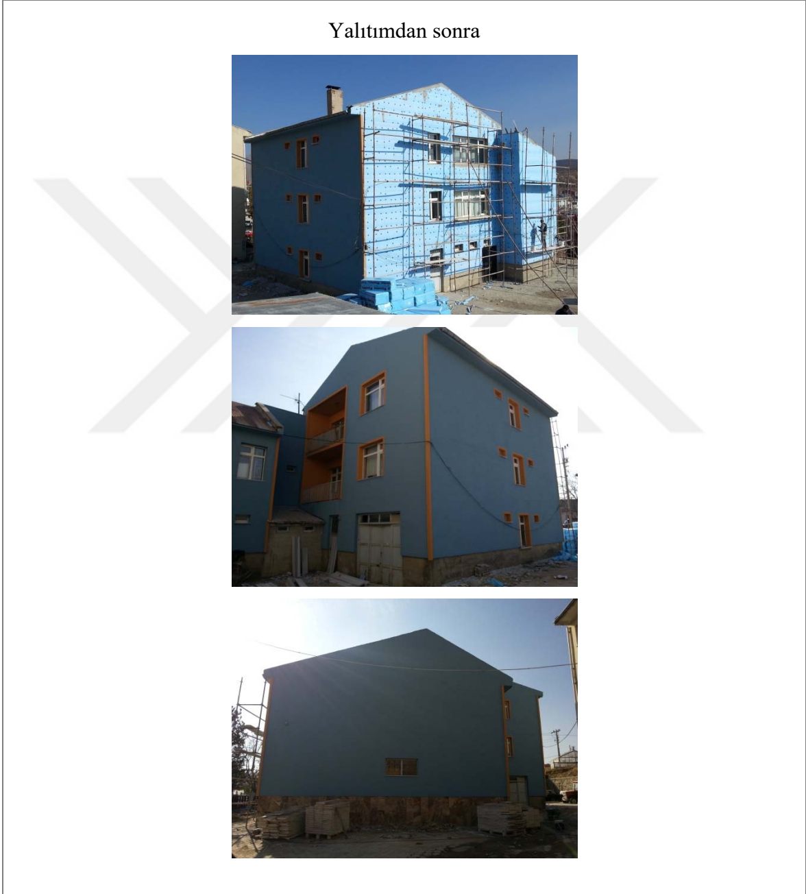
Şekil 2.104. Binanın dıştan yalıtımlı haldeki görüntüleri
