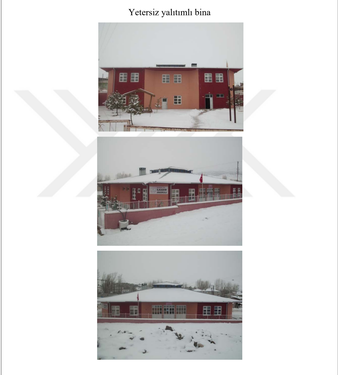
Şekil 2.91. Binanın dıştan yalıtımsız haldeki görüntüleri
