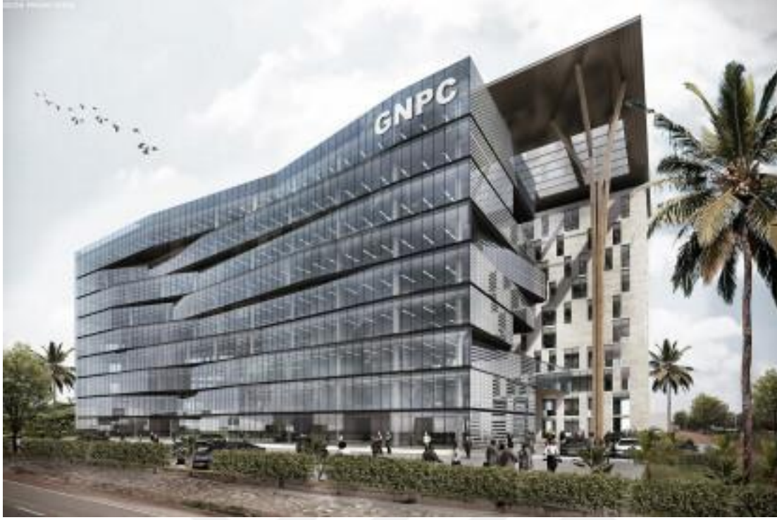
Şekil 2.24. Akra'daki GNPC genel merkezinin YBM projesi
