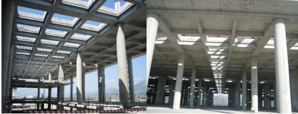
Resim 4.26. Dalaman hava limanı yeni dış hatlar terminali yapım strüktürü
