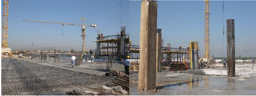
Resim.5.5 Temmuz ayı inşaat ilerlemesi
