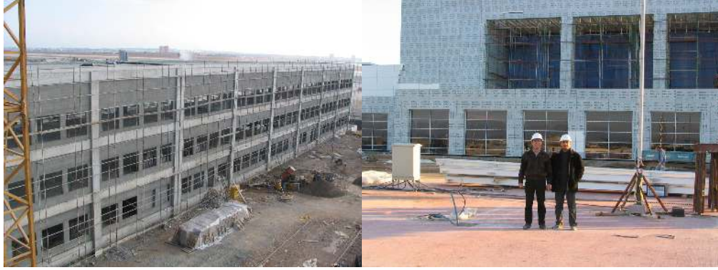
Resim 4.28. Duvar ve cephe kaplaması imalatı
