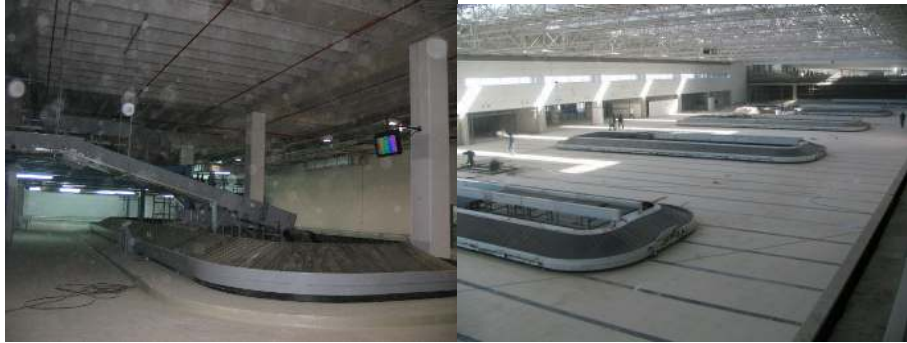
Resim 4.14. Bagaj toplama sistemi ve konveyörleri montajı
