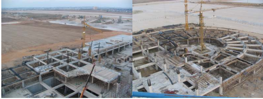
Resim 4.22. Terminal bloğu ve iskele bloğu kaba inşaat aşaması
