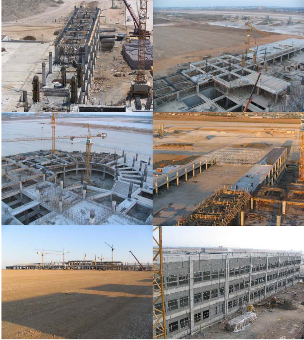
Resim.5.8 Eylül ayı inşaat ilerlemesi
