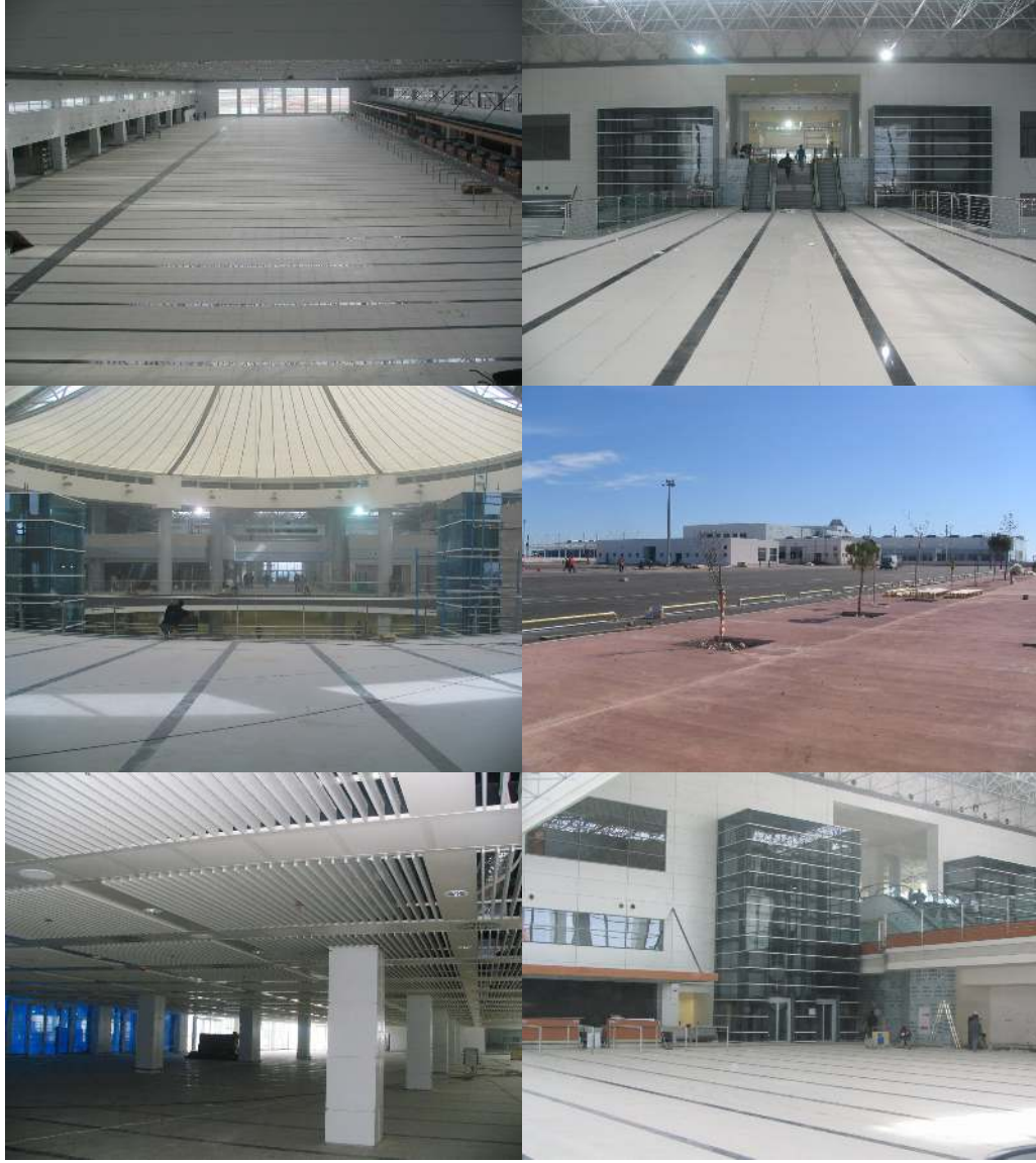
Resim.5.12 Şubat ayı inşaat ilerlemesi
