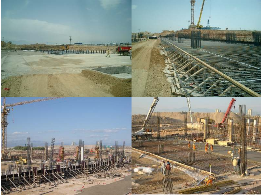
Resim.5.2 Mayıs ayı inşaat ilerlemesi
