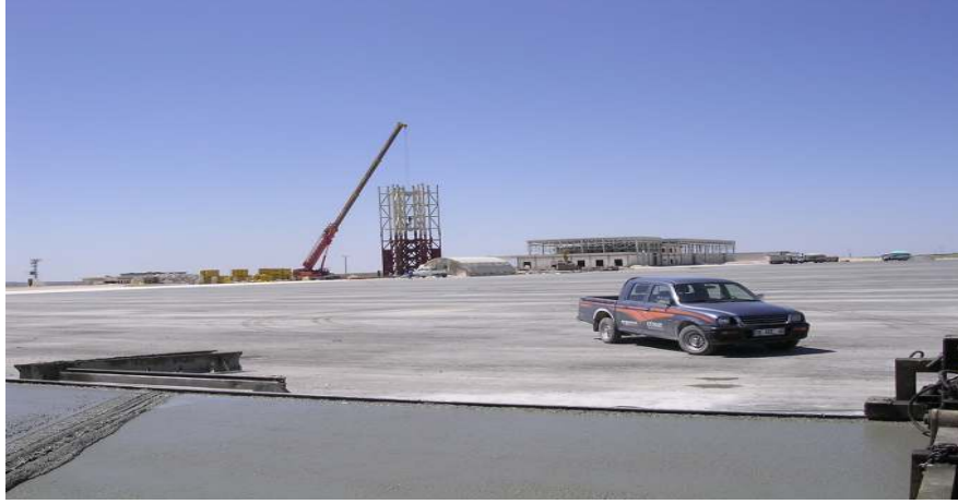
Resim 2.2. řanlıurfa GAP Havalimanı yapım fotoėrafı
