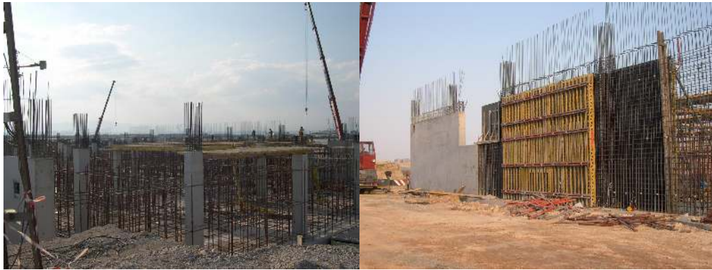
Resim.5.3 Haziran ayı inşaat ilerlemesi
