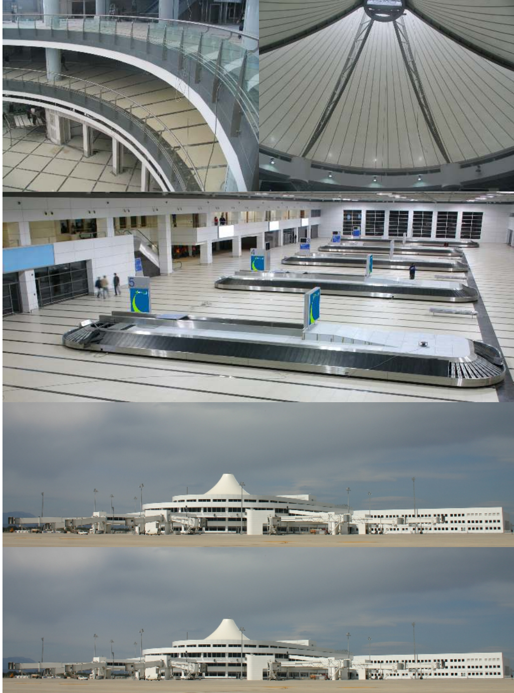
Resim.5.13 Şubat ayı inşaat ilerlemesi
