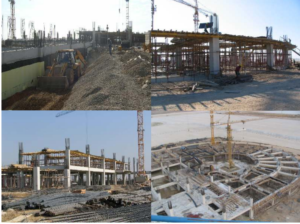
Resim.5.6 Temmuz ayı inşaat ilerlemesi
