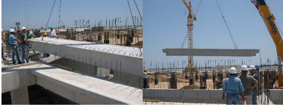
Resim 4.24. Prekast döşeme imalatı
