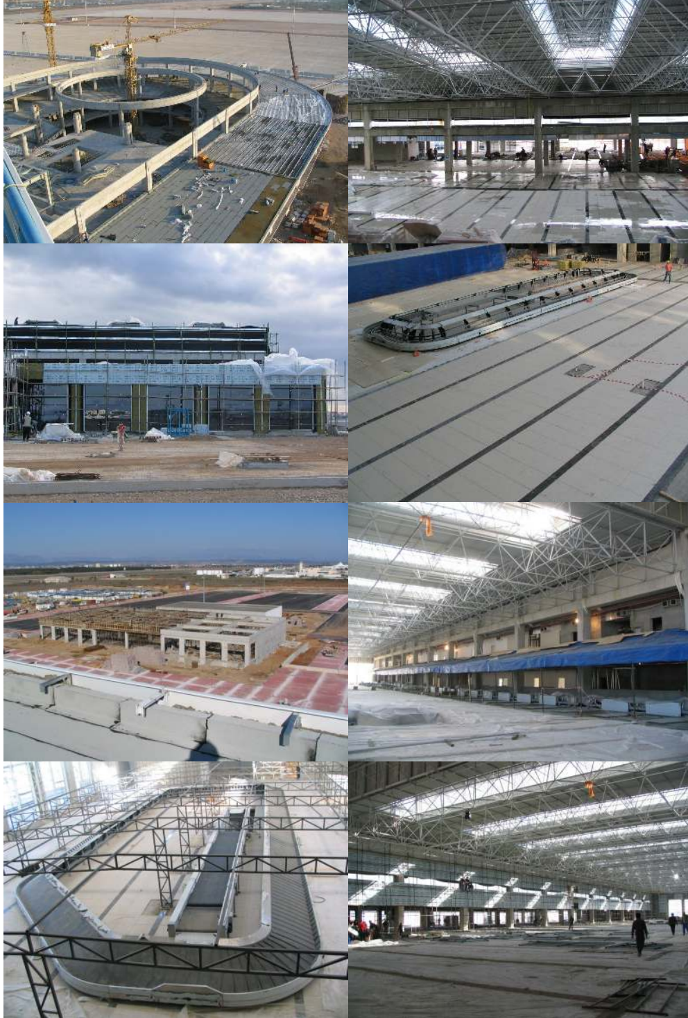
Resim.5.10 Aralık ayı inşaat ilerlemesi
