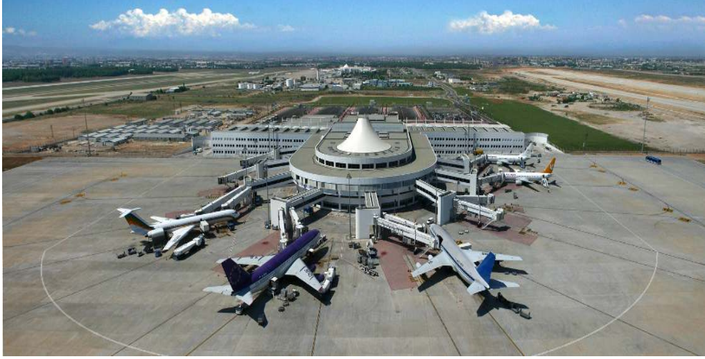
Resim 4.17.Terminal binası apron-hava-tarafından görünüş
