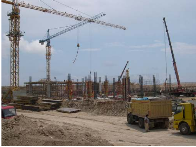
Resim 4.10. Antalya 2.Dış Hatlar Terminali yapım fotoğrafı nisan 2004
