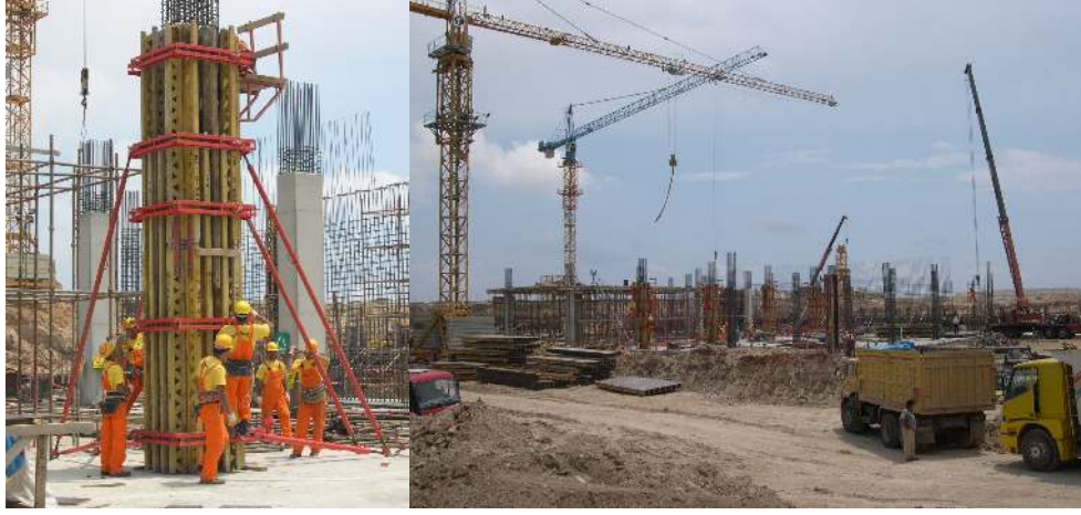
Resim 4.27. Kalıp tekniđi ve kule vin kullanımı
