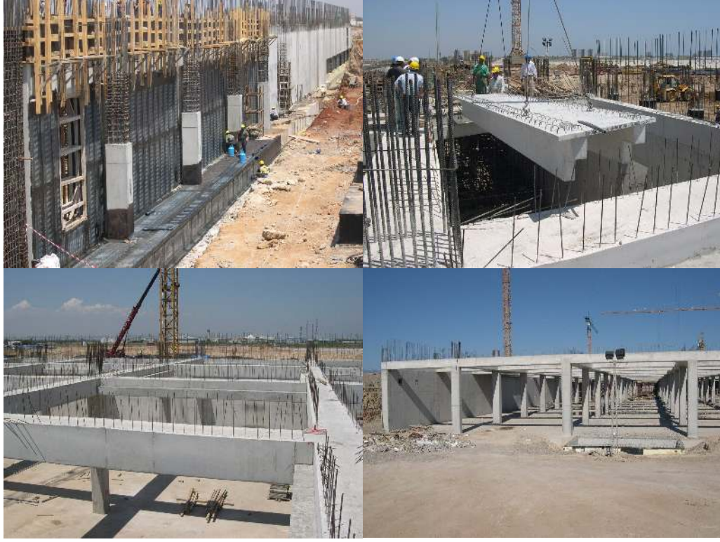
Resim.5.4 Haziran ayı inşaat ilerlemesi
