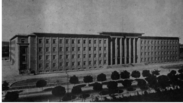
Şekil B. 59 DDY İdare Binası'nın yapıldığı döneme fotoğrafı [256]
