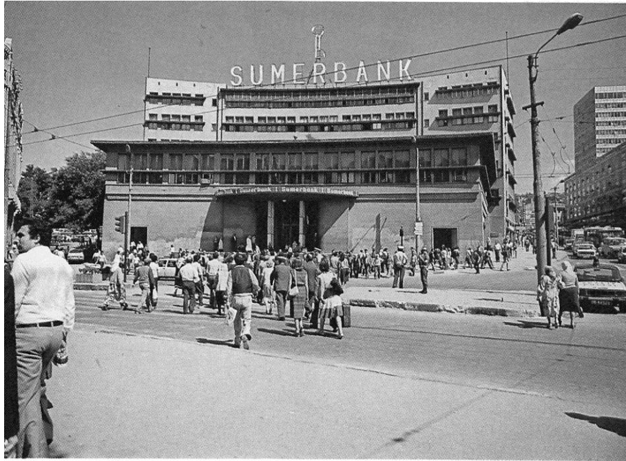
Şekil 3. 4 Ulus Sümerbank Binası (Ankara) [30]
