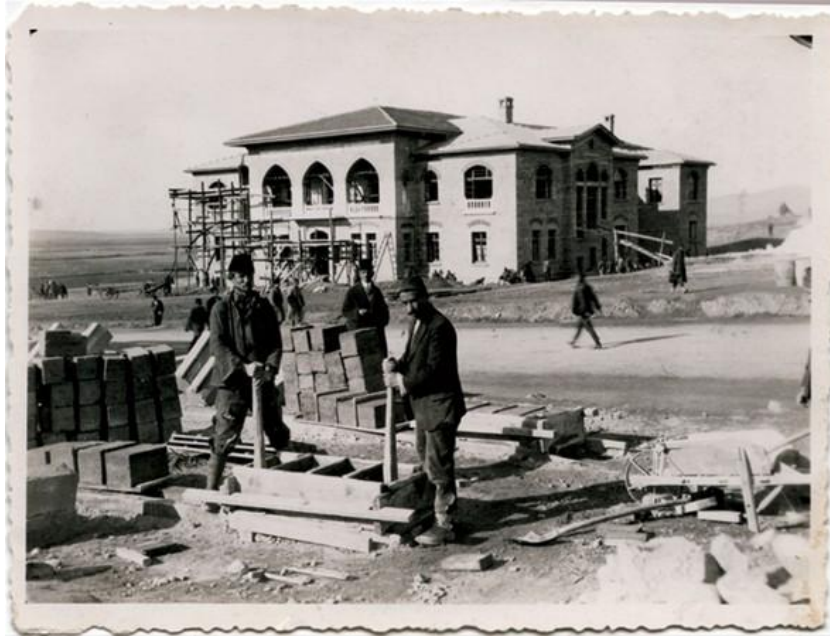
Şekil 3. 7 Ankara’daki inşa çalışmalarından (1924) [42]
