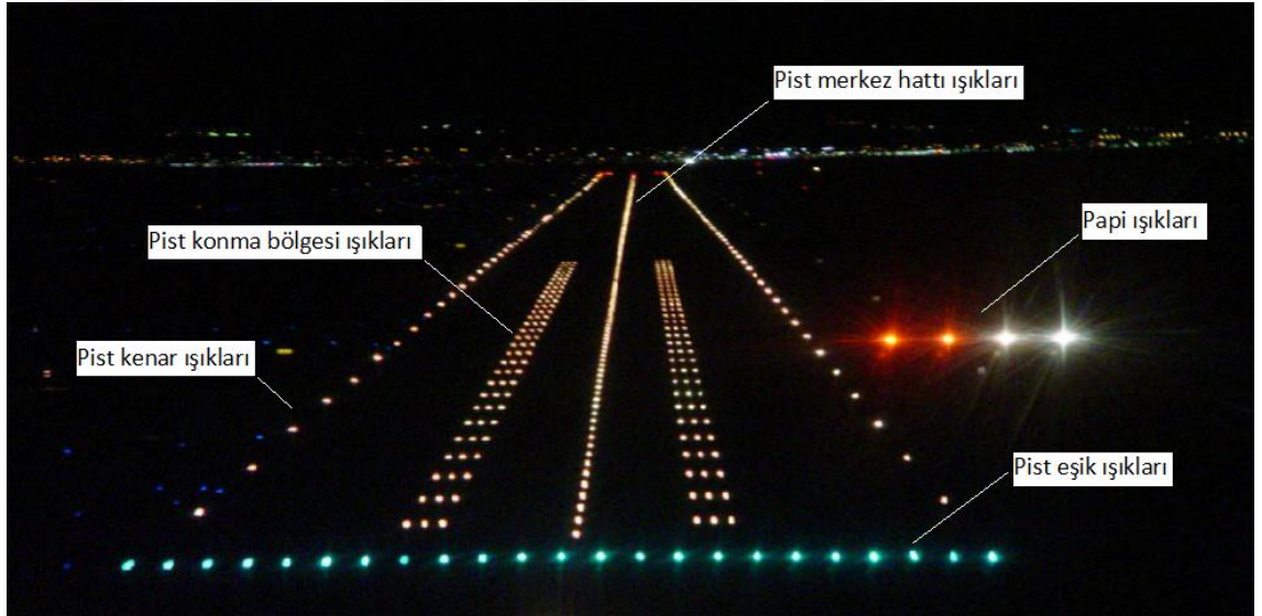
Şekil 3.11 Pist kenar, pist eşik, pist merkez hattı, tekerlek temas ve papi ışıklarının yerleşimi (DHMİ 2014)
