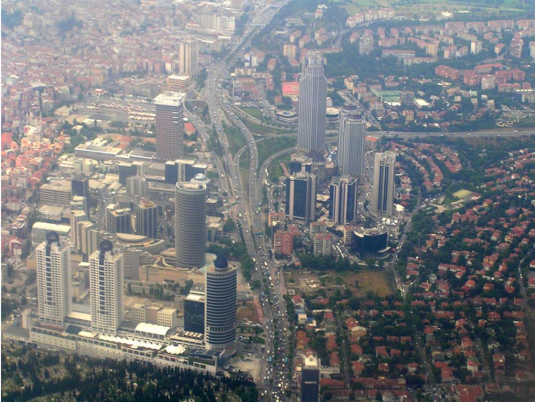
Şekil 3.8 : Güney- kuzey doğrultusunda Büyükdere Caddesi, sol önde Metrocity AVM, sağ önde Levent Çarşı Meydanı ve Levent Konutları hava fotoğrafı(Url-6).
