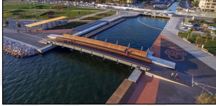
Şekil 4.5 Bostanlı Yaya Köprüsü ve Gün Batımı Terası (Arkitera, 2023a)
