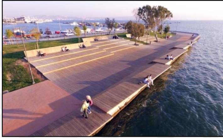
Şekil 4.8 Bostanlı Yaya Köprüsü ve Gün Batımı Terası (Arkitera, 2023b)
