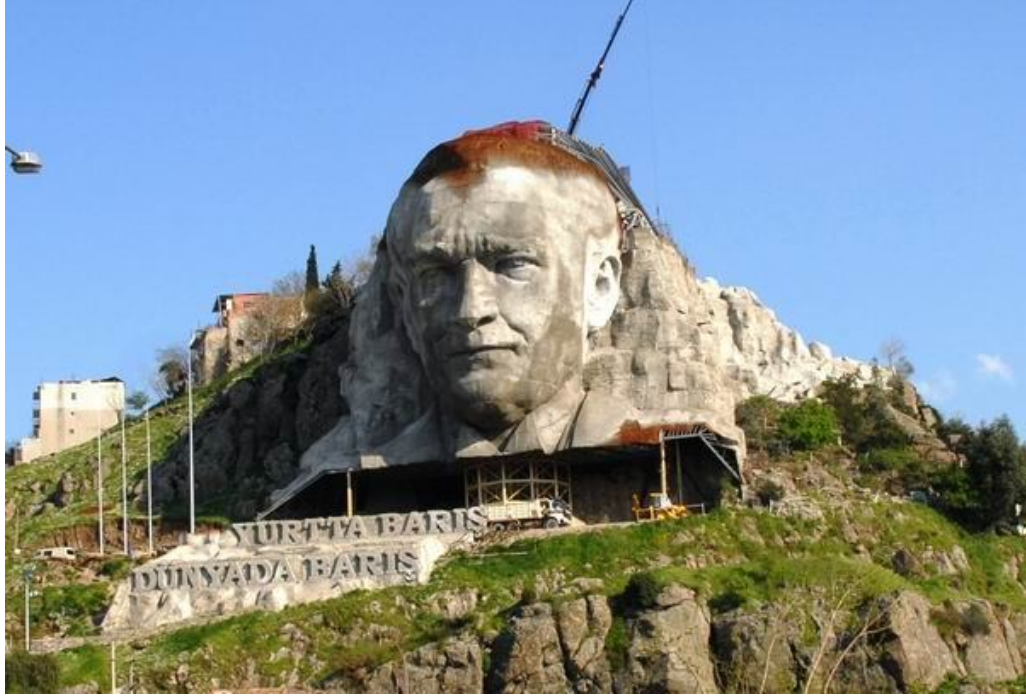
Resim 57. Harun Atalayman, Atatürk maskı, çelik kafes üzerine beton püskürme, 40m, 2009, Buca, İzmir.
