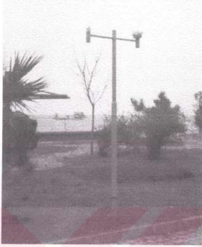
Şekil 30. 6. Gözlemde A26'nın fiziksel durumu
