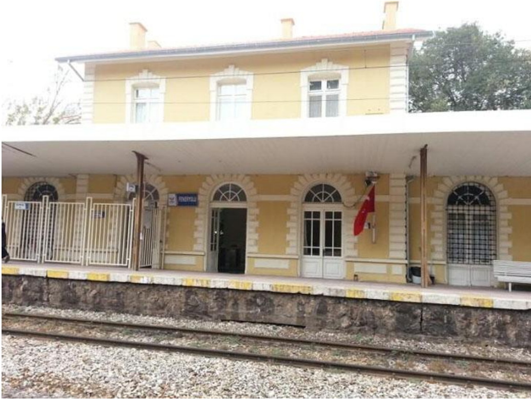
Şekil 3.15 Feneryolu Tren İstasyonu
