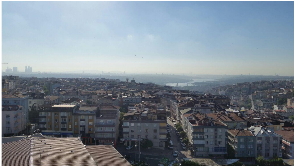
Şekil 4.3 : Gaziosmanpaşa Meydanı'ndan Haliç'e bakış (AO, 2015).
