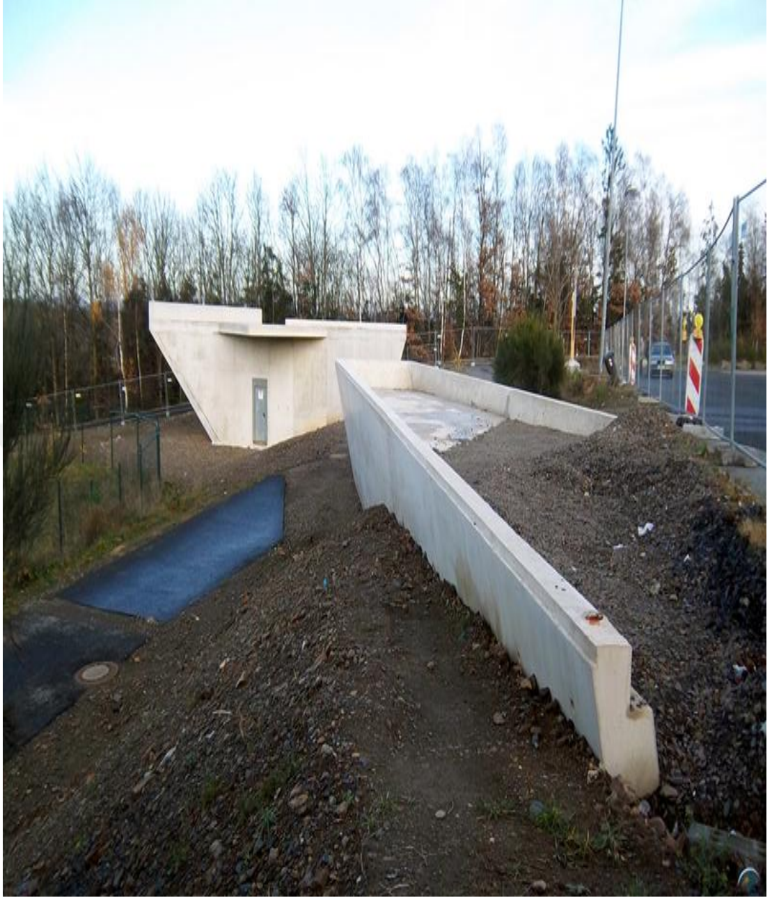
Fotoğraf.40. Zemin Betonu (URL.31.)
