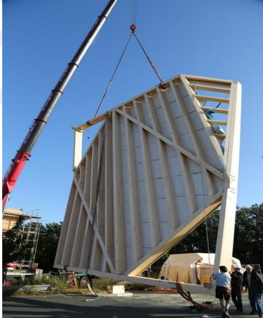
Fotoğraf.42. Karkas Sistem Montajı (URL.33.)
