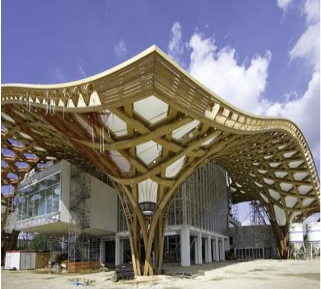
Fotoğraf.26. Centre Pompidou Metz Konsol ve Zemin Bağıntısı (URL.17.)
