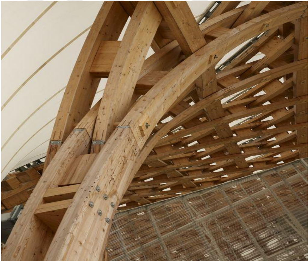
Fotoğraf.25. Centre Pompidou Metz Ahşap Birleşim Detayı (URL.16.)
