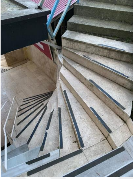
Şekil 52. Aydınlıkevler Camisi'ne ulaşmak için mahalle merdivenine yapılan ek (Kaynak: Gülçin Eren Arşivi, 2023)
