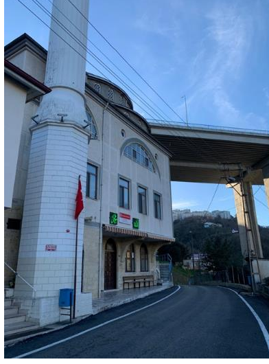
Şekil 54. Aydınlıkevler Camisi'nin yol ile ilişkili batı cephe görünüşü (Kaynak: Gülçin Eren Arşivi, 2023)
