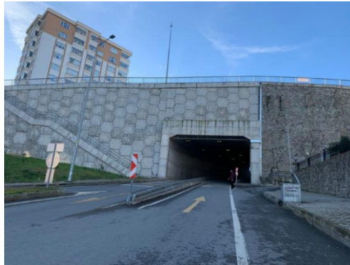
Şekil 82. Siyamoğlu Sokak'tan Kanuni Bulvarı köprüyol altı geçişine giriş (Kaynak: Gülçin Eren Arşivi, 2023)
