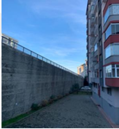
Şekil 83. Bulvarın kuzey yönünde, yolun alt kotunda kalan apartmanlar zeminden görünüş (Kaynak: Gülçin Eren Arşivi, 2023)
