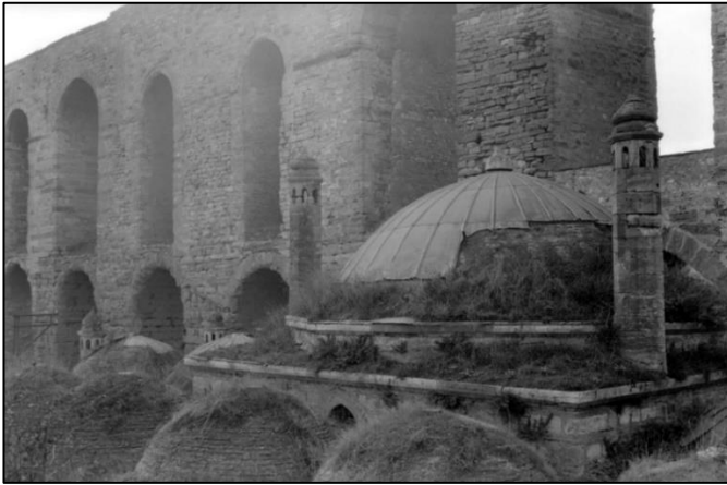
Fotoğraf 4.6. Kırkçeşme Gazanfer Ağa Medresesi Örtü Sistemi, Encümen Arşivi, 1934
