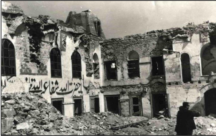
Fotoğraf 4.63. Eskiğediz Gazanfer Ağa Camisi Onarım Öncesi Durumu (Vakıflar Genel Müdürlüğü Arşivi)
