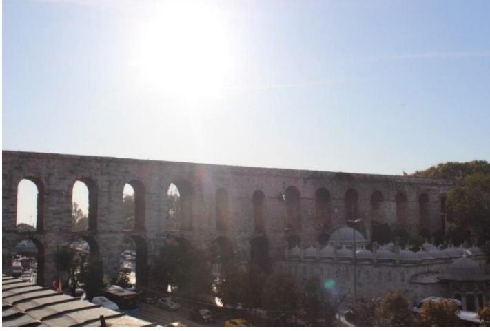
Fotoğraf 4.13. Kırkçeşme Gazanfer Ağa Külliyesi'nin Doğudan Bakışla Güney Yönü
