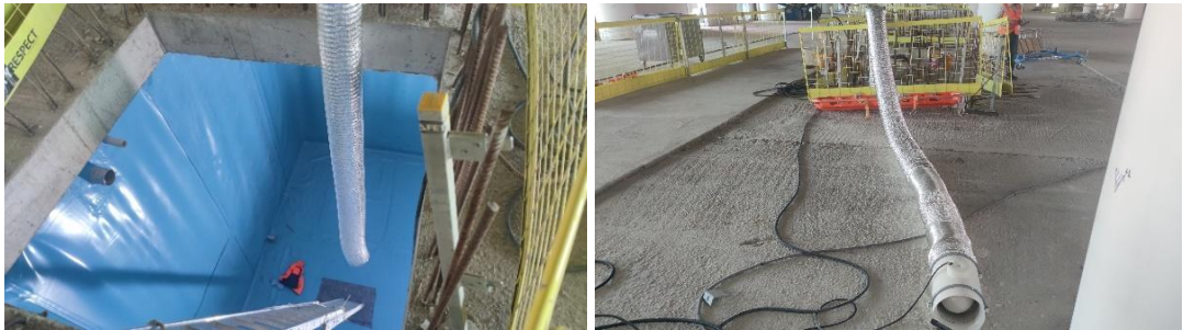
Şekil 14. Kapalı ve Kısıtlı Alan Havalandırma Örneği
