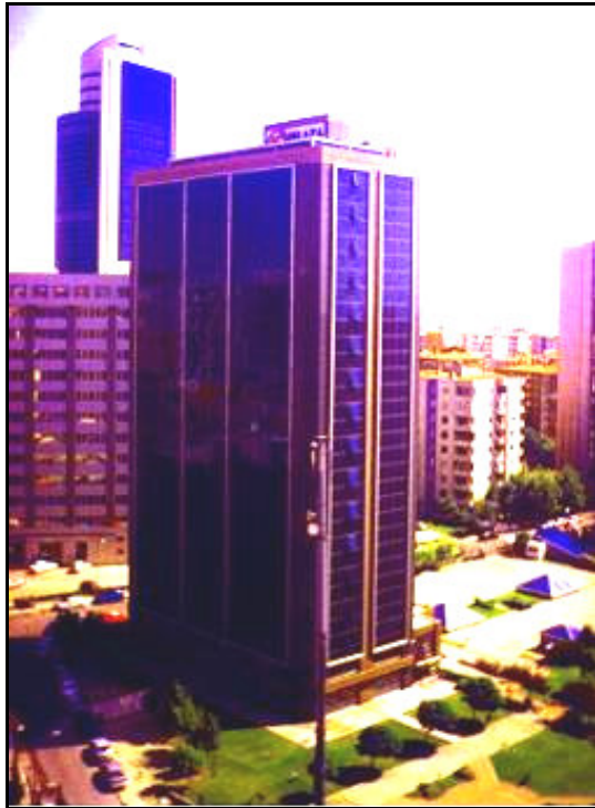
Resim 3.1. K3 Plaza Center ofis binasının dış cephe görünüşü
