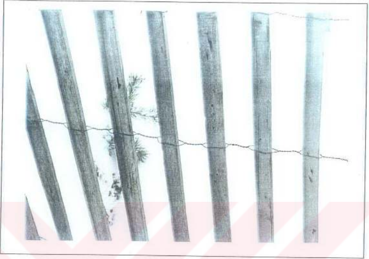
Ek 3.10: Kanada Tipi Perdenin Birleşim Detayı
