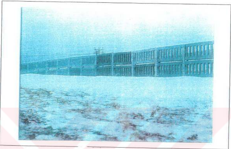
Ek 2.1: Betonarme kar perdesi (R., Sarıkaya, 1997, sözlü görüşme)
