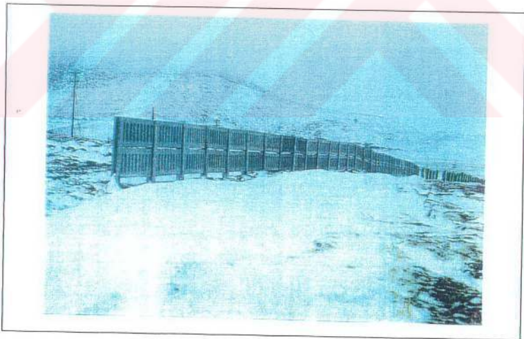
Ek 2.2: Betonarme kar perdesi (R., Sarıkaya, 1997, sözlü görüşme)
