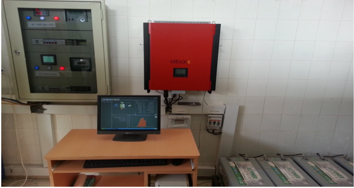
Şekil 7.2. Hibrid dize inverter ve sistem bileşenleri
