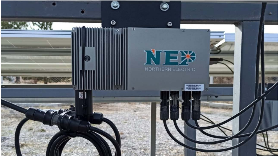
Şekil 7.7. Mikro inverter montajı
