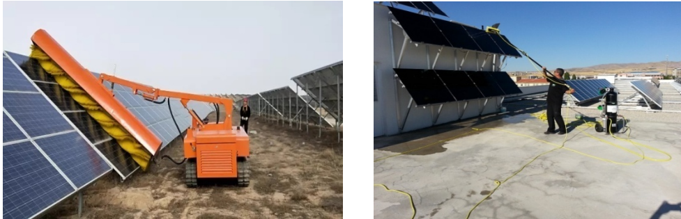
Şekil 5.5. Panel yüzeyinin temizliği 17
