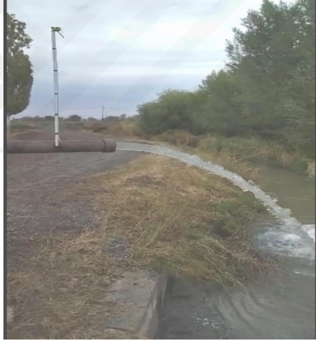
Şekil 2.3. Su sondaj kuyularında dinamik seviye bulma çalışmaları
