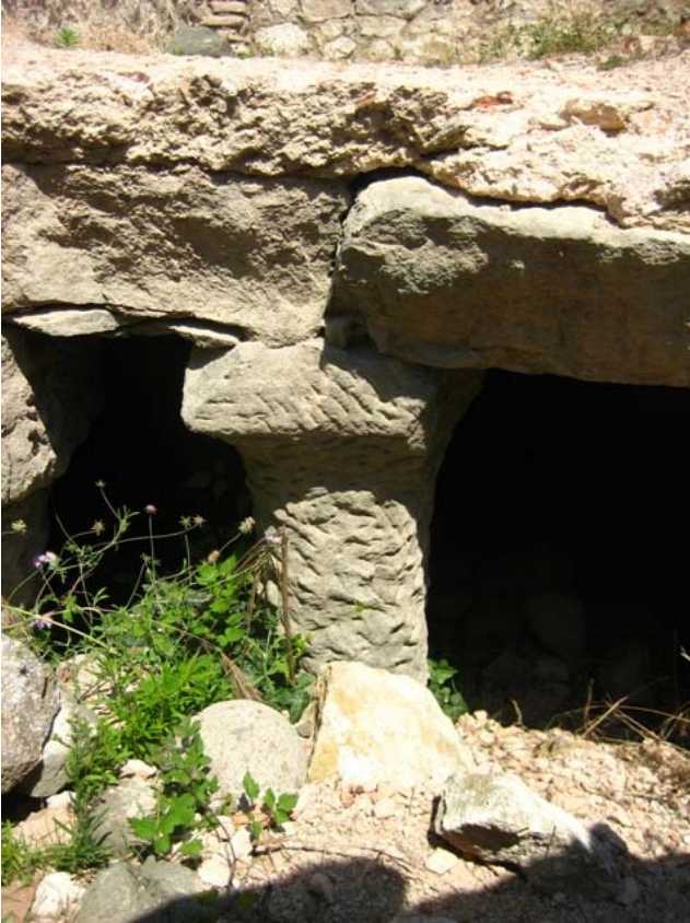
Resim 4.5. Tios (Filyos) kenti hamam yapısında bulunan taş taşıyıcı ayaklar ve üzerlerinde yer alan döşemenin kesiti (Fotoğraf: Biçer)
