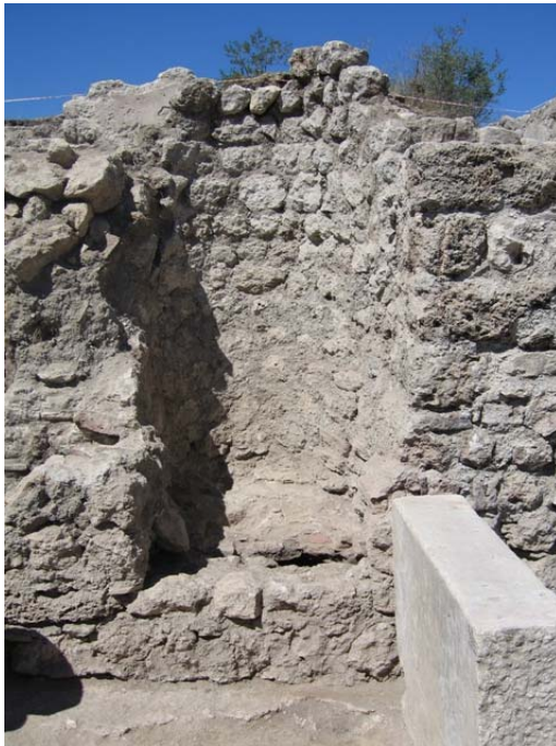
Resim 4.3. “Hamam A” yapısında bulunan niş (Fotoğraf: Kazı arşivi)
