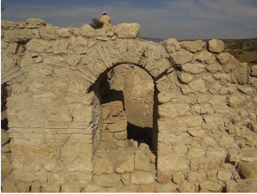
Resim 3.11. Yapının duvar kenarlarında ve kemerlerinde kullanılan kaba yonu kesme taş (Fotoğraf: Biçer)
