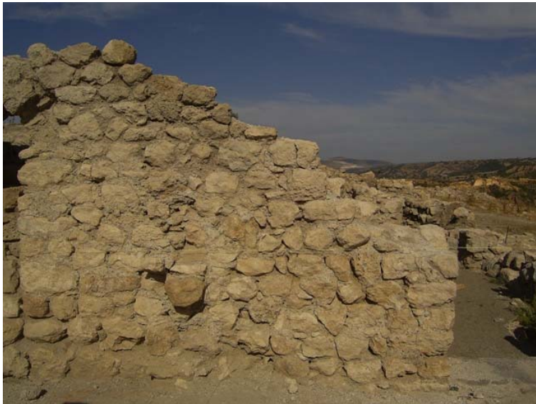
Resim 3.33. Yapının moloz taş duvar örgü tekniği (Fotoğraf: Biçer)
