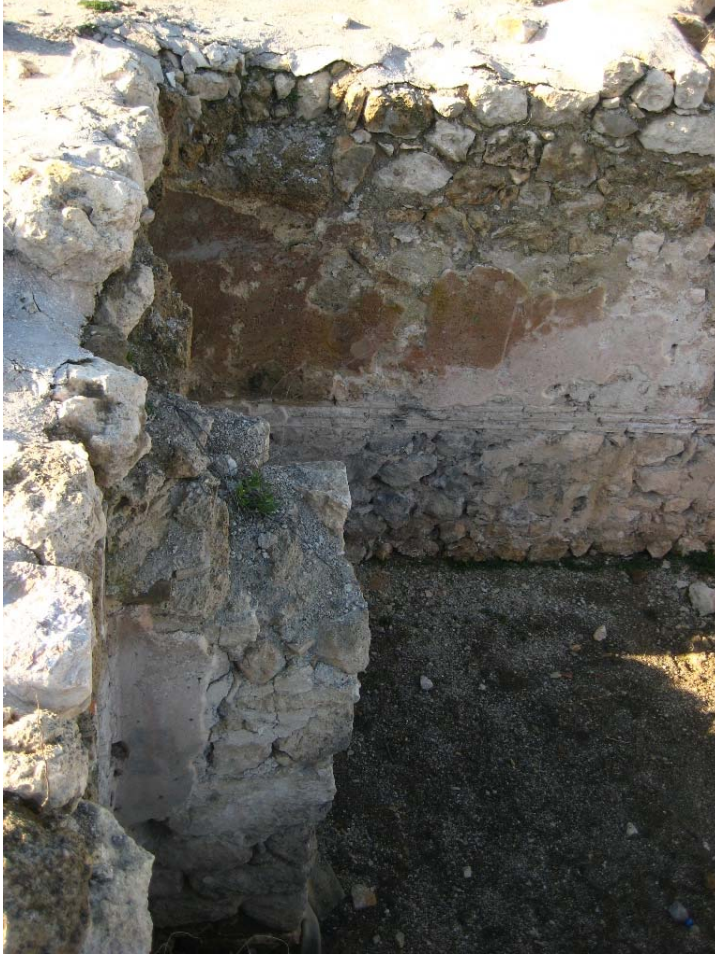
Resim 5.17. Yapı duvarlarında yer alan “stucco siva” kalıntıları ve yüzeyindeki farklı renk tonu (Fotoğraf: Biçer)
