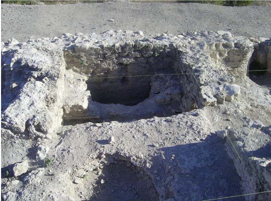
Resim 3.41. Yapının duvar ve zemininde meydana gelen bozulmalar ve malzeme kaybı (Fotoğraf: Biçer)
