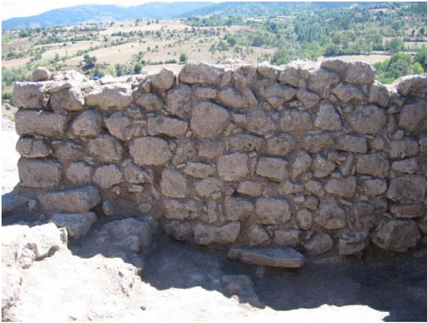
Resim 3.12. Yapıya sonraki dönemlerde eklenen mekanların moloz taş duvar yapısı (Fotoğraf: Kazı arşivi)
