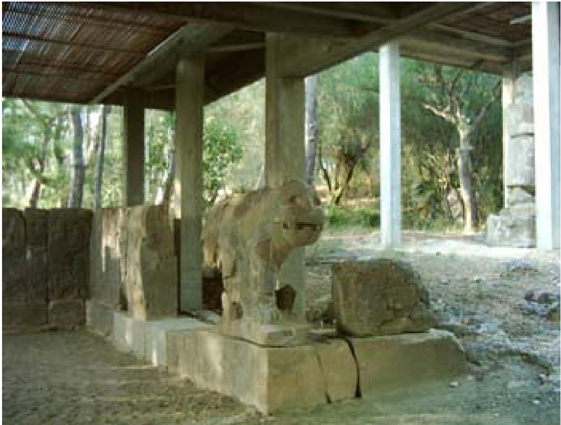
Resim 6.2. Karatepe açık hava müzesinde uygulanan koruyucu çatı örneği
