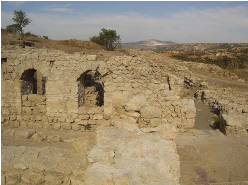
Resim 3.10. Yapının moloz taş duvarlarından bir görünüm (Fotoğraf: Biçer)
