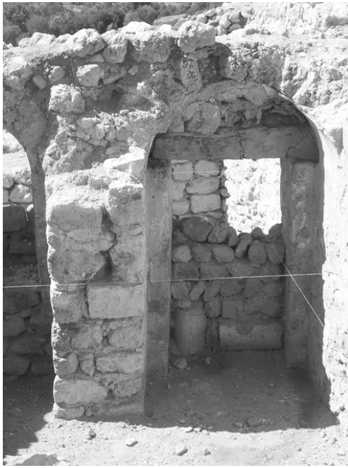
Resim 5.10. Kemer altlarında yer alan, devşirme taşlardan oluşturulmuş geç dönem duvarları (Fotoğraf: Biçer)
