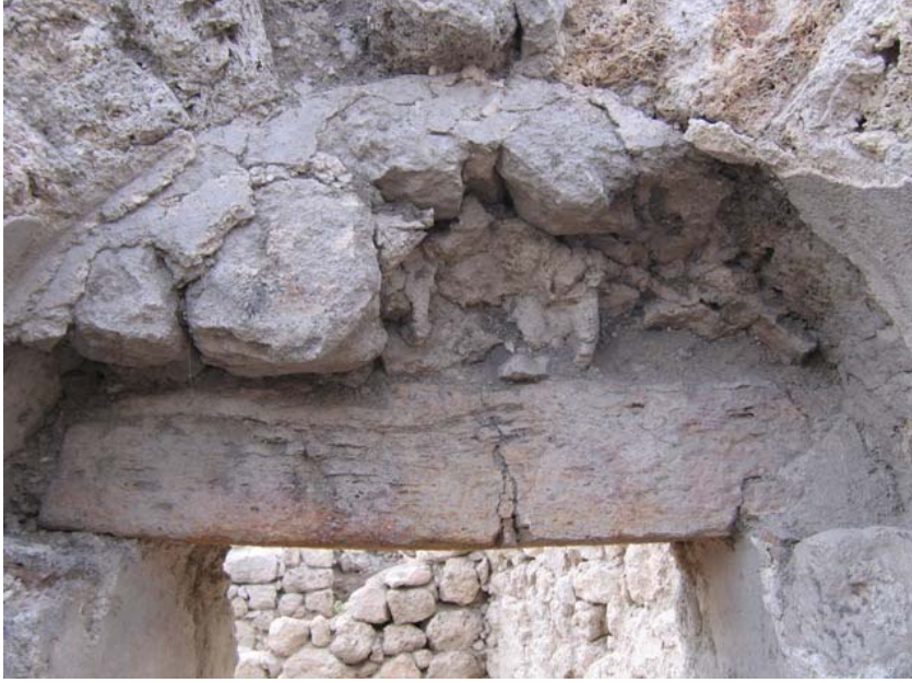
Resim 3.37. Lentoda meydana gelen yapısal bozulma (Fotoğraf: Biçer)
