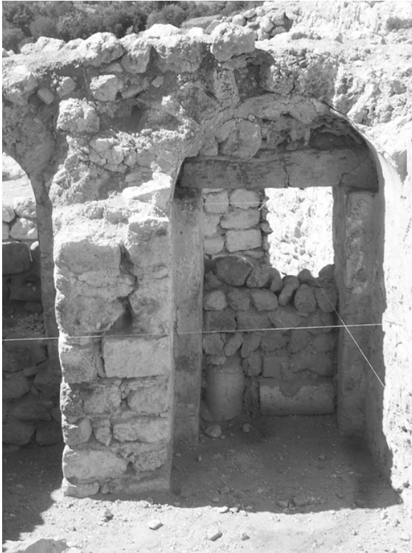
Resim 3.22. Yıkılmış olan payanda kemerlerinin izleri (Fotoğraf: Biçer)
