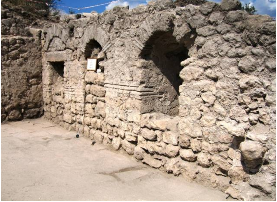
Resim 3.6. M 10 ve M 11 mekanları arasında kalan üç kemerli taş duvar ve taşlar arasında kullanılan tuğla malzeme (Fotoğraf: Kazı arşivi)
