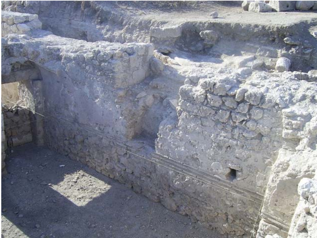
Resim 5.11. Soyunmalık mekanının tonoz örtü sistemine ilişkin yapısal izler (Fotoğraf: Biçer)
