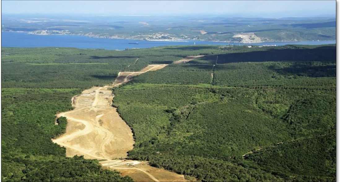
Şekil 21. Kuzey Marmara Otoyolu İnşaatı (Megaprojeleristanbul.com,2002).
