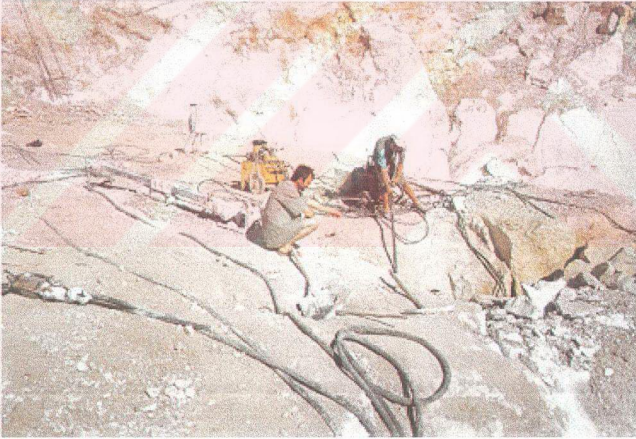
Şekil.3.12 Tel kesme ile tüm yüzeyleri kesilmiş mermer bloğun devrilmesi için hidrolik titano bomlarının yerleştirilmesi.
