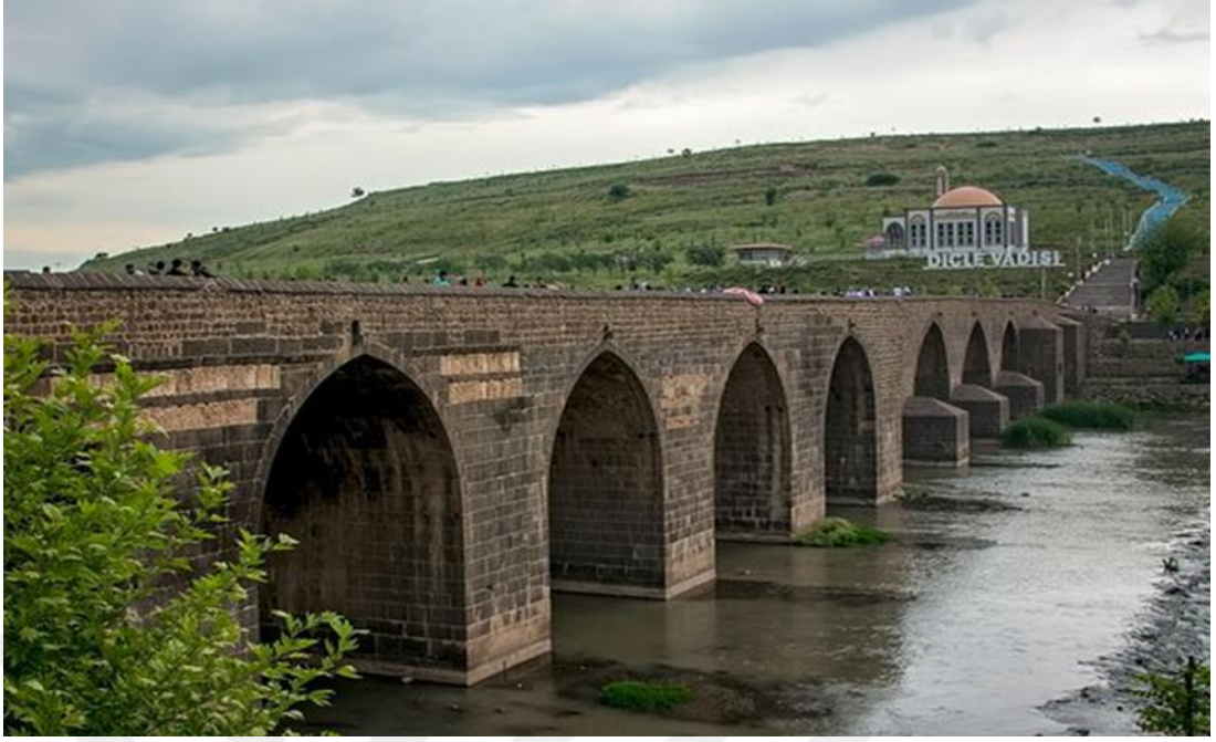
Şekil 1.11: On Gözlü Köprü
