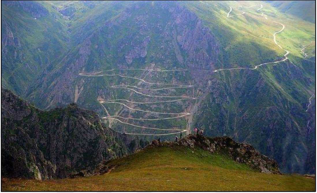
Şekil 56. Çaykara-Karaçam Derebaşı mevkiinde yer alan dünyanın en tehlikeli 4. yolu Derebaşı virajlarından bir görünüm (kaynak: http://www.dangerousroads.org/europe/turkey/3923-bayburt-of-yolu-d915.html ).
