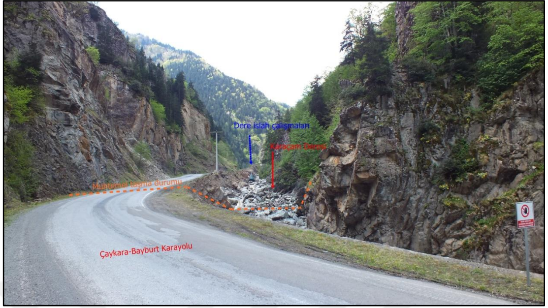
Şekil 77. Çamlıbel Boğazı'nda akarsuyun muhtemel taşkın alanı ve dere ıslah çalışmaları (güneye bakış).
