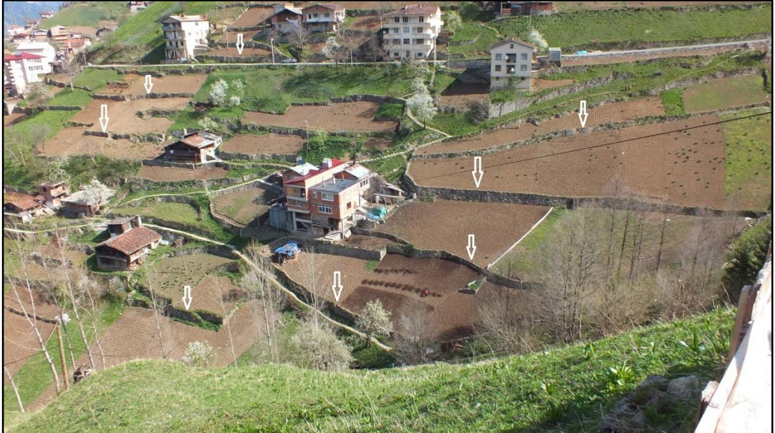
Şekil 67. Karaçam-Saadet mahallesinde yöre insanı tarla önüne duvar örerek toprak kaybını önlemektedir.
