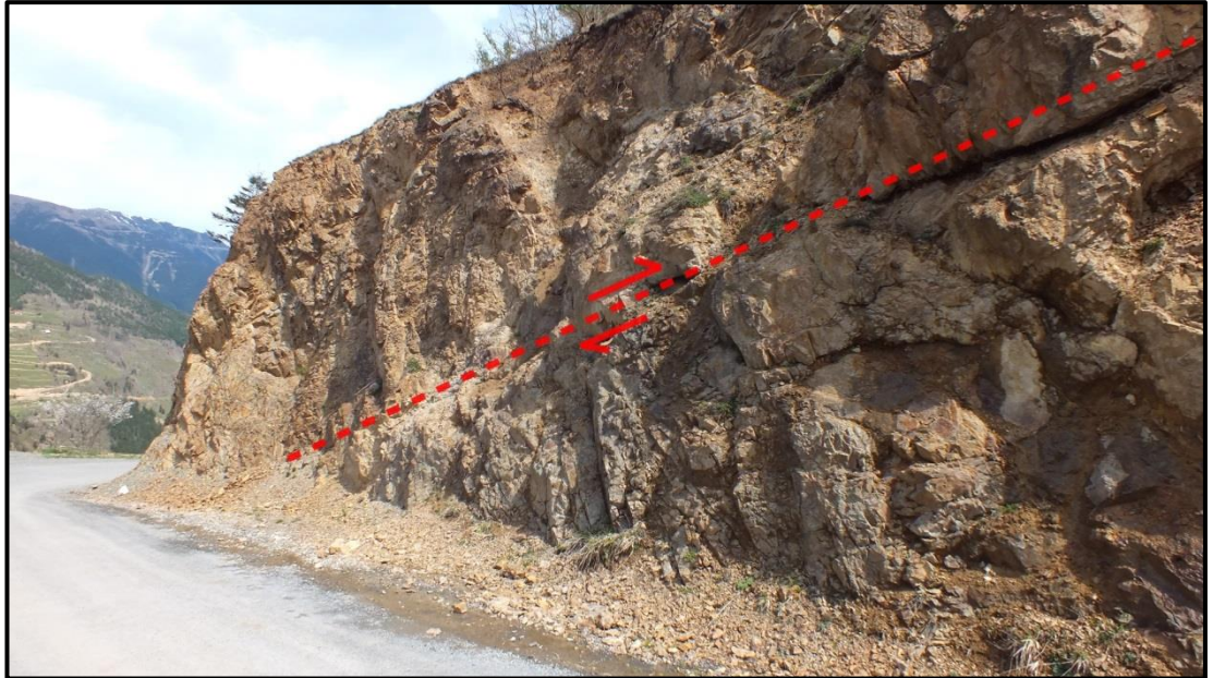
Şekil 14. Karaçam yerleşkesi girişinde yer alan faydan bir görünüm (doğu yamaç).
