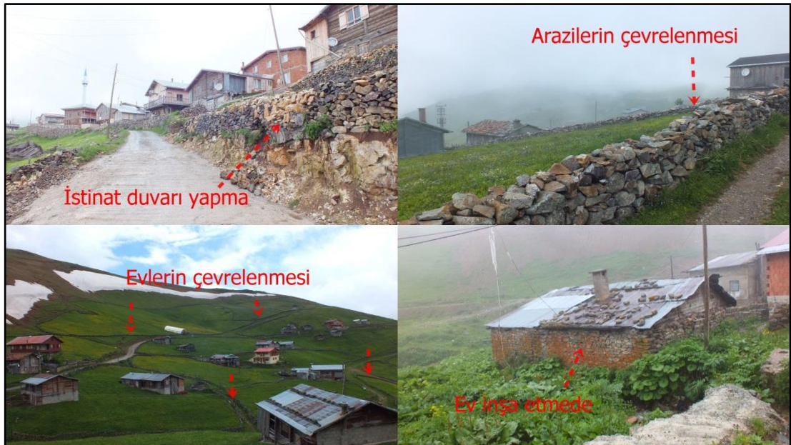
Şekil 48. Şekersu'da konjelifraksiyon olayı sonucunda parçalanmış kayanın kullanım yerlerinden görünüm.
