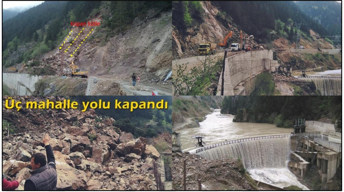
Şekil 80. Çamlıbel Mahallesi'nin 2 km ilerisinde Çamlıkaya HES su toplama alanının hemen yan tarafında meydana gelen heyelan (kaynak: http://www.caykaragazetesi.com ).
