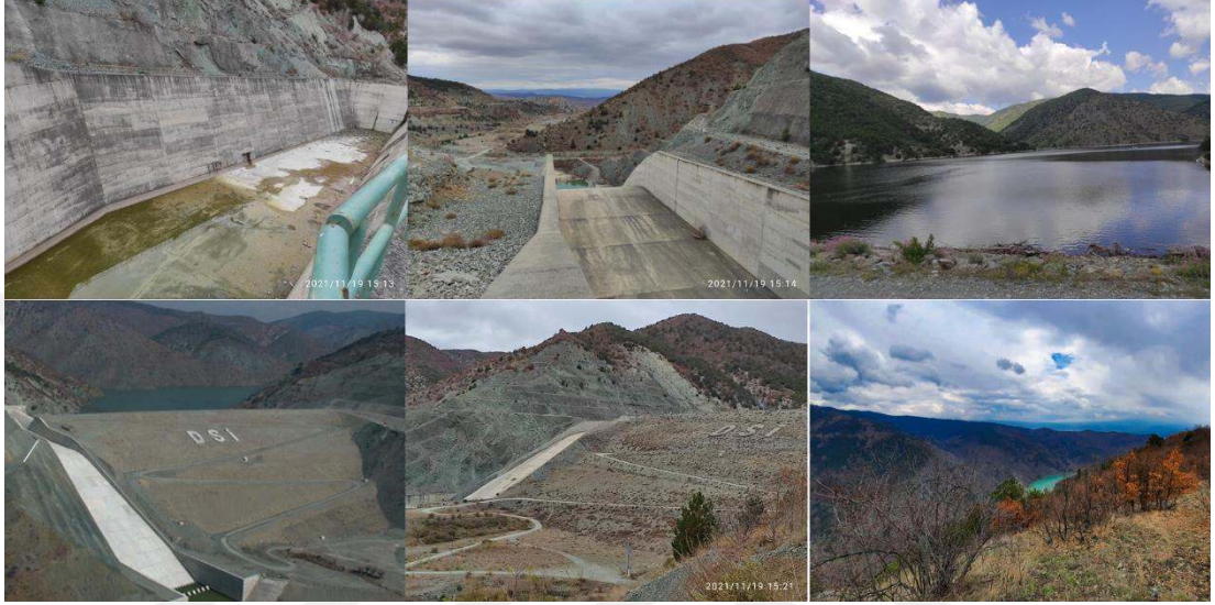
Şekil 0.1 Karadere Barajı gövdesi, savaklar ve baraj gölü
