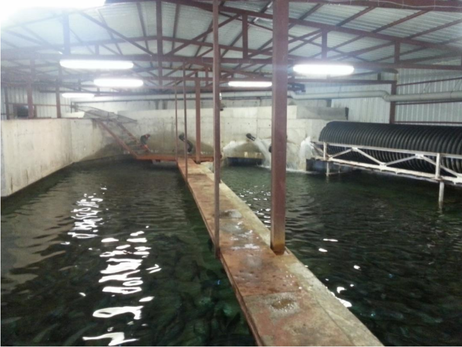
Resim 1.2. Bir kara tesisinde beton anaç havuzları
