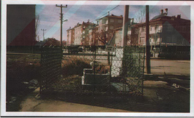
Resim 4 : Garip Dede Türbesi
