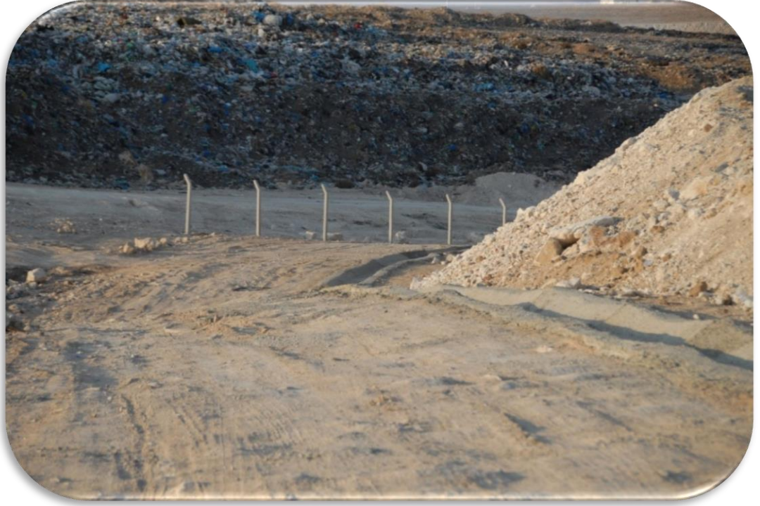
Şekil 11.2. Tesis ulaşım yolu yapım alanları.
