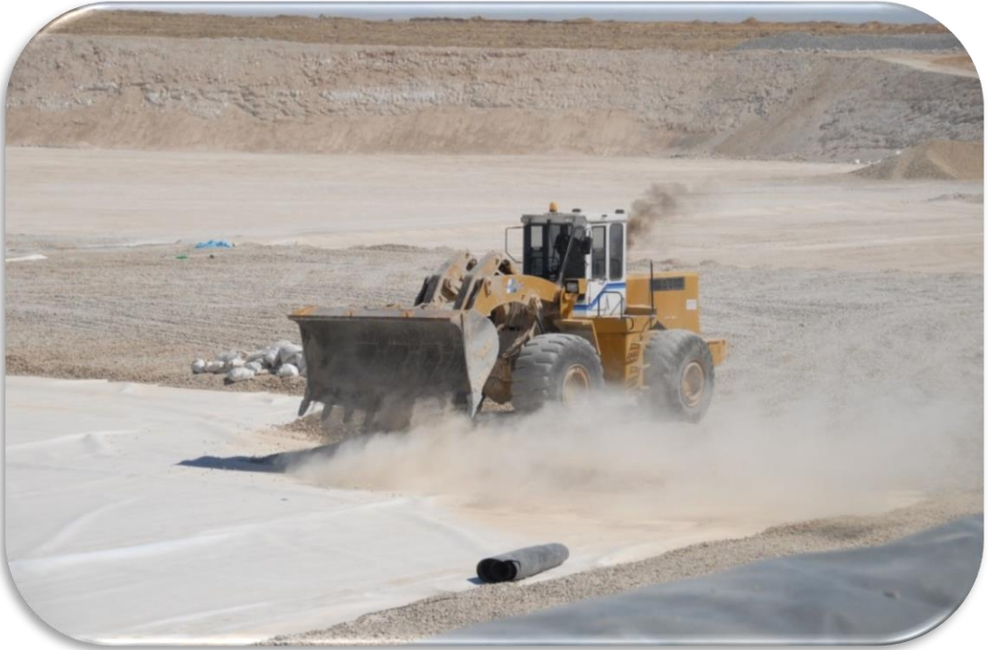
Şekil 11.4. Geomembran serilme alanları.
