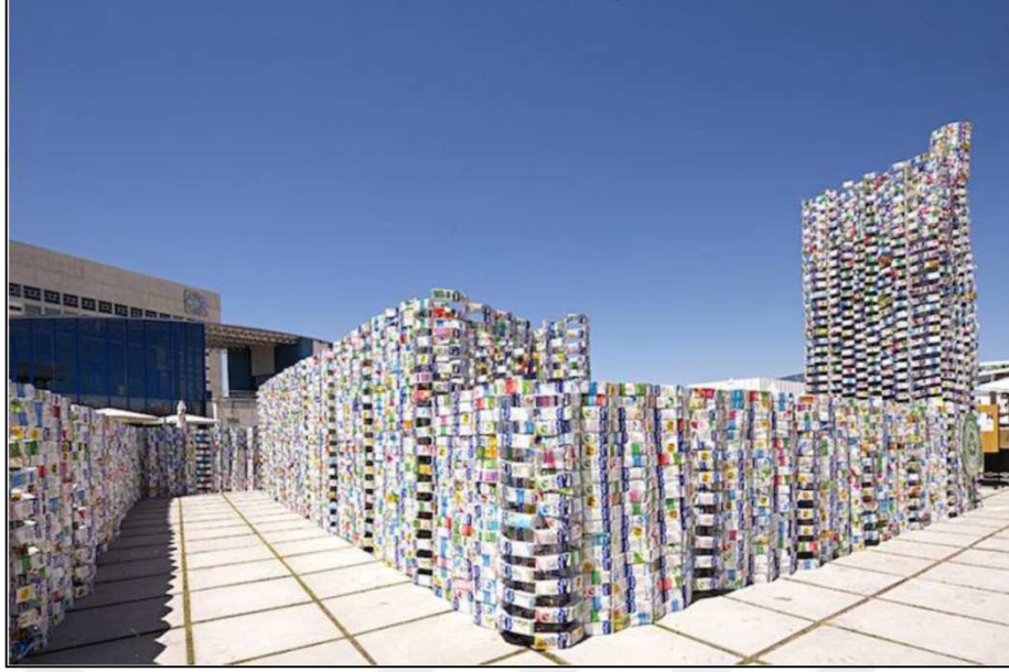
Şekil 2.18. Geri dönüştürülmüş materyallerden oluşan inşa.
