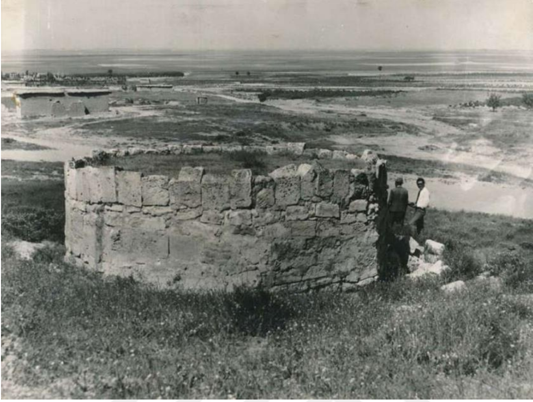
Şekil 93. Saliha Hatun Türbesi (İbrahim Hakkı Konyalı)
