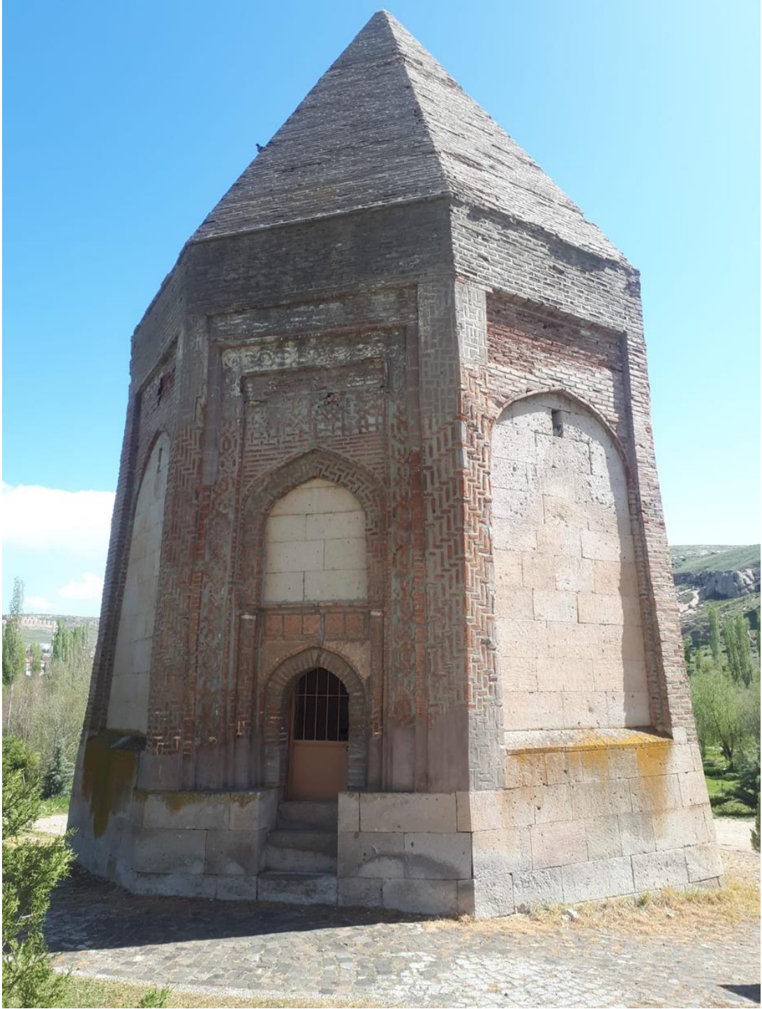
Şekil 91. Selime Sultan Türbesi (Alaattin Köse 09.05.2025)
