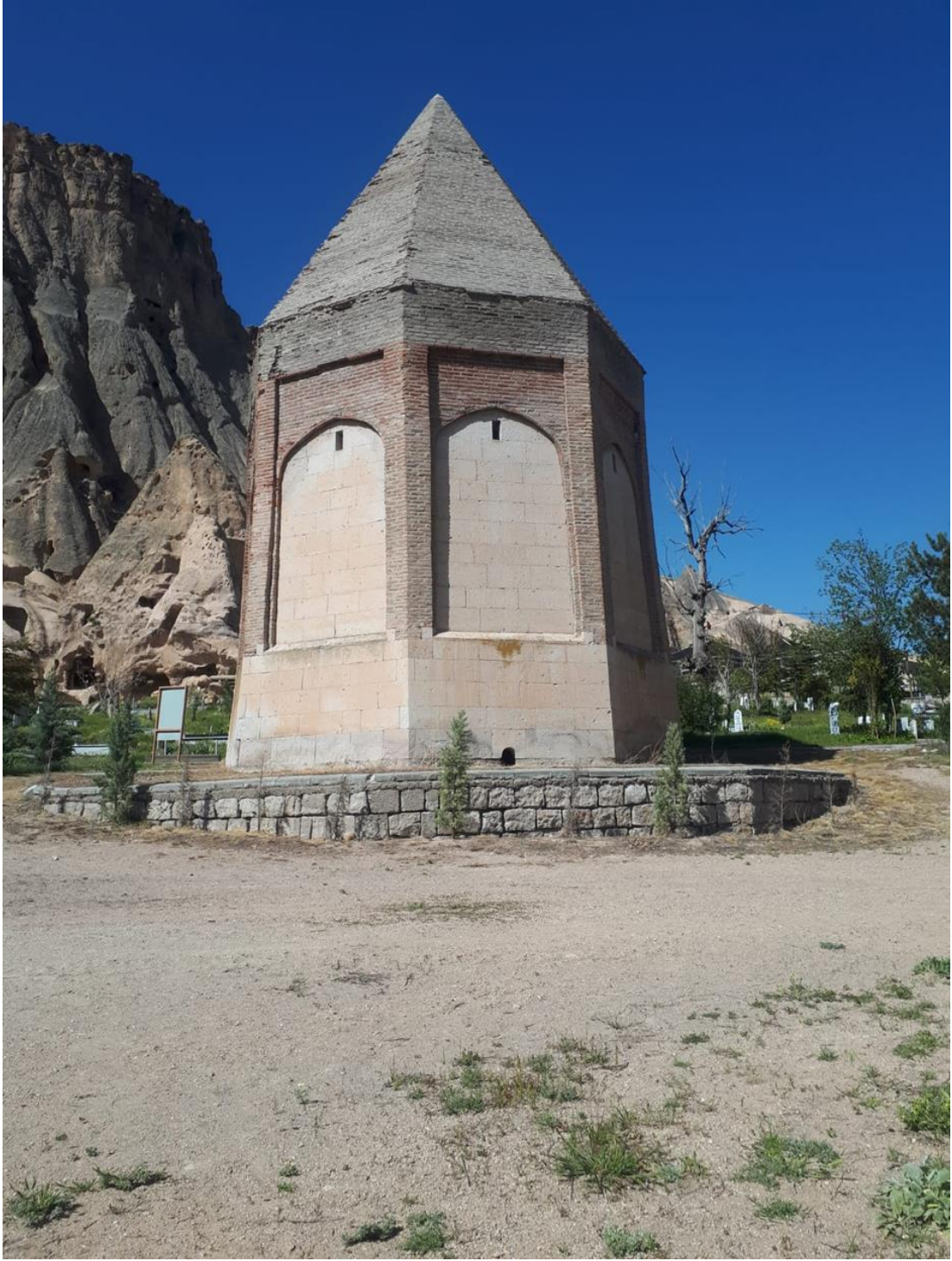
Şekil 92. Selime Sultan Türbesi 2 (Alaattin Köse 09.05.2025)
